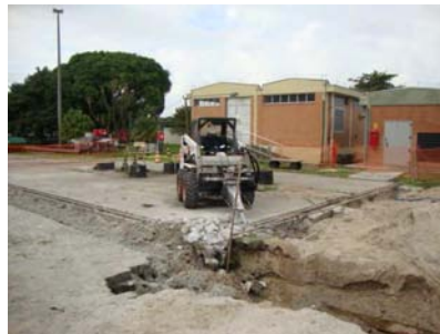
Imagem 02 - O pátio de concreto sendo removido.
