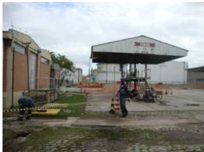
Imagem 01 - Área a ser remediada. Antiga plataforma de distribuição de diesel (desativada).
