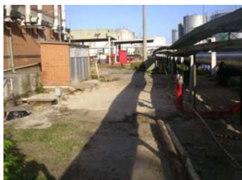
Imagem 04 - Zona recebendo o solo novo para o fechamento das cavas.
