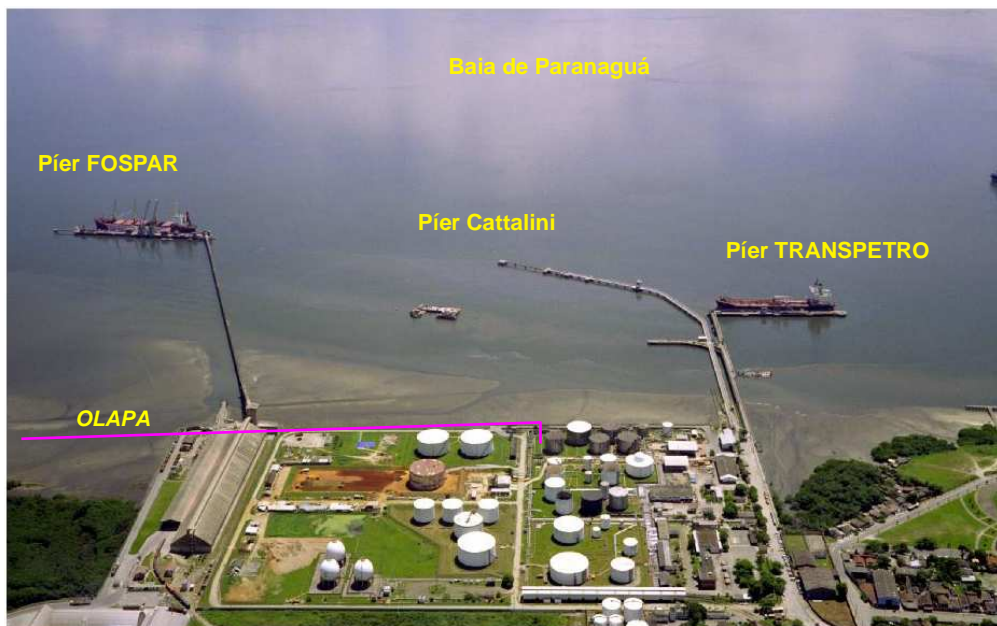
FIGURA 10 – VISTA AÉREA DO TERMINAL AQUAVIÁRIO DE PARANAGUÁ – 2007 FONTE: Relatório da ESSENCIS - ETR200903051500MSV – Diagnóstico Ambiental 2009 NOTA: Estágio de instalação do tanque 60212 na área 60, ainda sem pintura.
