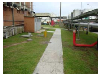
Imagem 05 - Área remediada já com cobertura vegetal.
