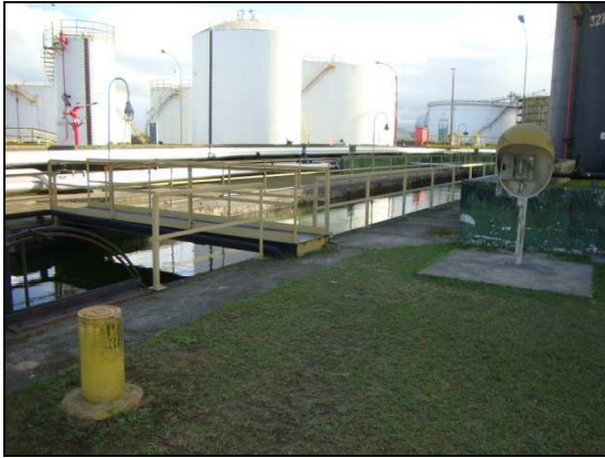
FIGURA 12 – O SISTEMA DE SEPARAÇÃO A.P.I SITUADO NA ÁREA 35, PRÓXIMO AO PRÉDIO DO ALMOXARIFADO
