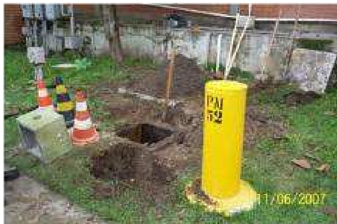
FIGURA 19– ESCAVAÇÃO REALIZADA PARA AVALIAÇÃO DAS CONDIÇÕES CONSTRUTIVAS DA CAIXA DE PASSAGEM
