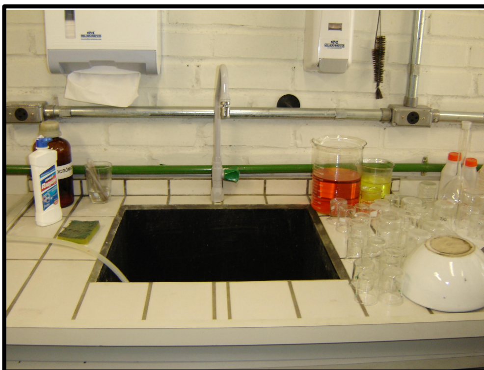
Figura 33 - Vista da nova pia após as modificações construída com material resistente a ácidos e álcalis.
