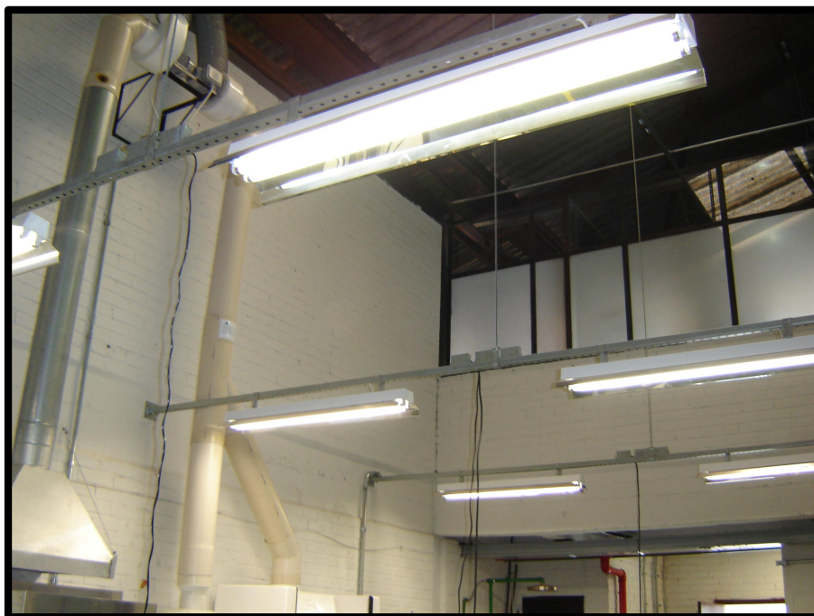
Figura 24 - Vista da melhoria da iluminação e dutos de saída de ar.
