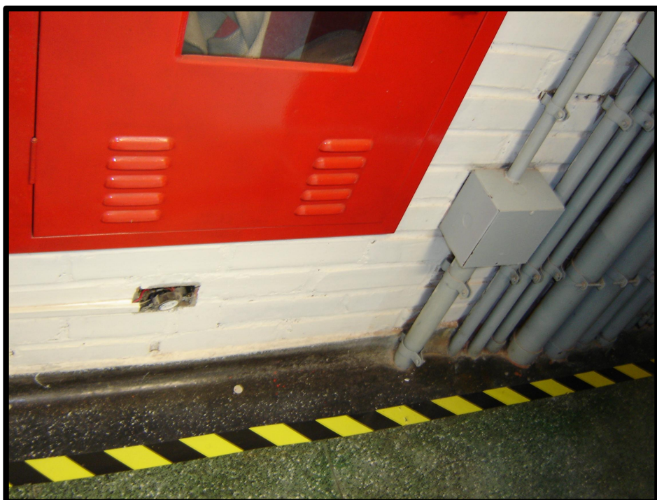
Figura 22 - Vista da demarcação de locais de trabalho e locais de segurança.
