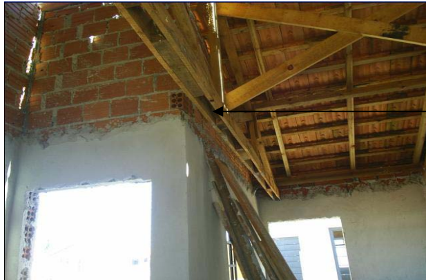
FIGURA 4.32 - TESOURA PRÓXIMA À ALVENARIA
