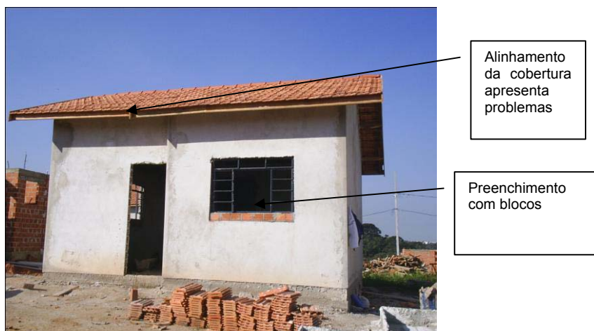
FIGURA 4.6 -UNIDADE EM CONSTRUÇÃO
