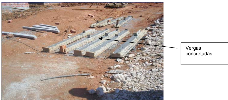
FIGURA 4.21 - CONCRETAGEM DAS VERGAS NO CANTEIRO
