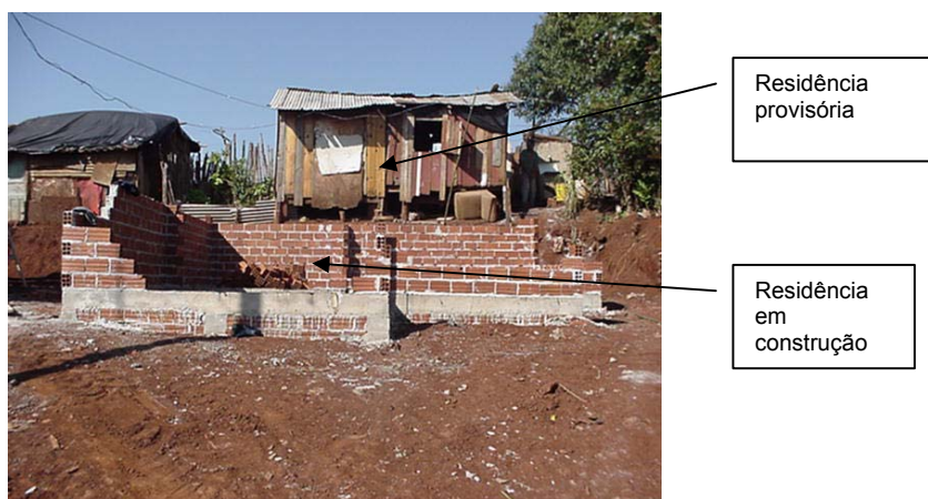
FIGURA 4.3 -CASA EM CONSTRUÇÃO COM HABITAÇÃO PROVISÓRIA
