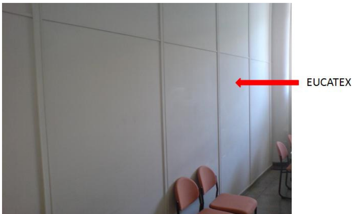
Figura 4.11 – Divisória Eucatex para a Separação de Ambientes Distintos
