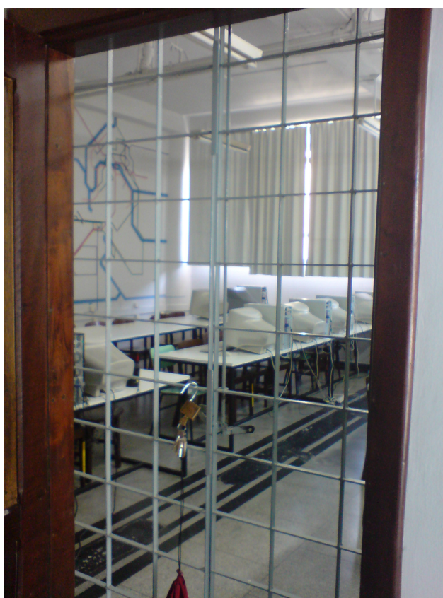
Figura 4.5 – Instalação da porta em grade metálica
