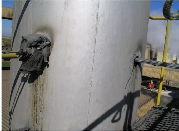
**Figura 32 - Detalhe das sondas de coleta**
