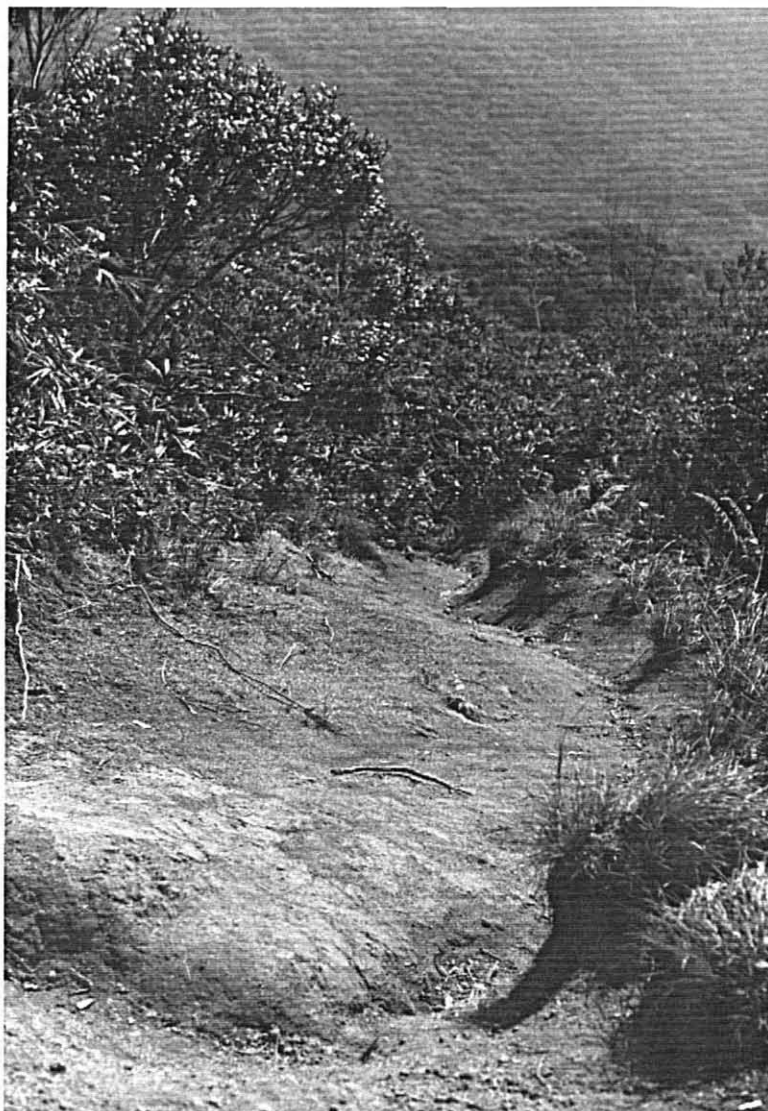
FIGURA 17: ASPECTO DA EROSÃO NA TRILHA AO PICO FACÃOZINHO
