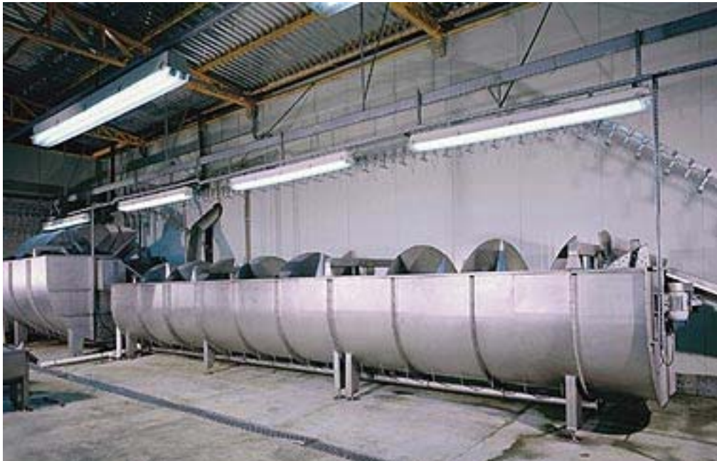
Foto 3 – Chiller, composto por Lavador, Pré-chiller e Chiller
