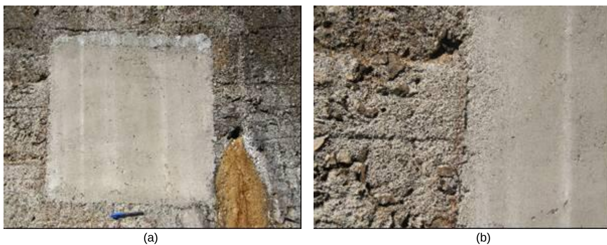
FIGURA 79 – PONTO DE APLICAÇÃO Nº. 5, MATERIAL DE REPARO: CONCRETO COM ADIÇÃO DE MATERIAL RECICLADO PET 5% (A). DETALHE DA BORDA DO MR E SUBSTRATO (B).
