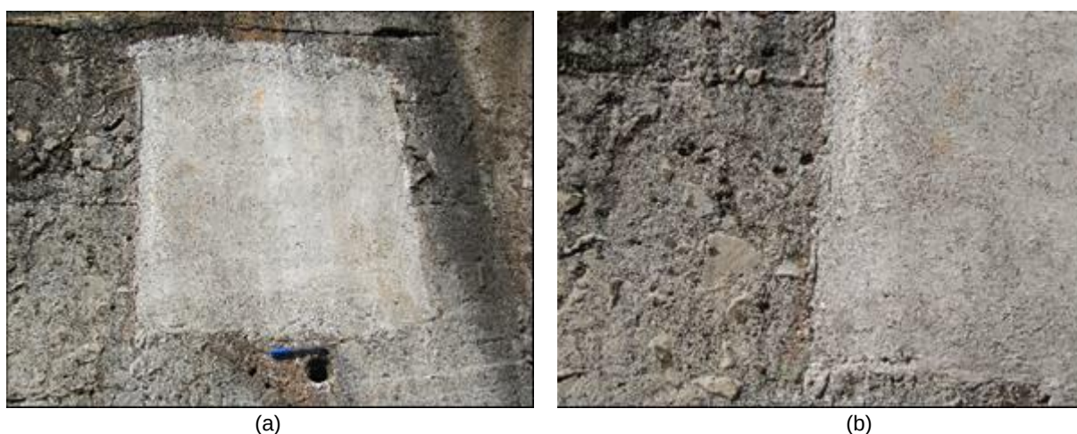
FIGURA 84 – PONTO DE APLICAÇÃO Nº. 10, MATERIAL DE REPARO: CONCRETO COM ADIÇÃO DE MICROFIBRA DE PE E PET. (A). DETALHE DA BORDA DO MR E SUBSTRATO (B).
