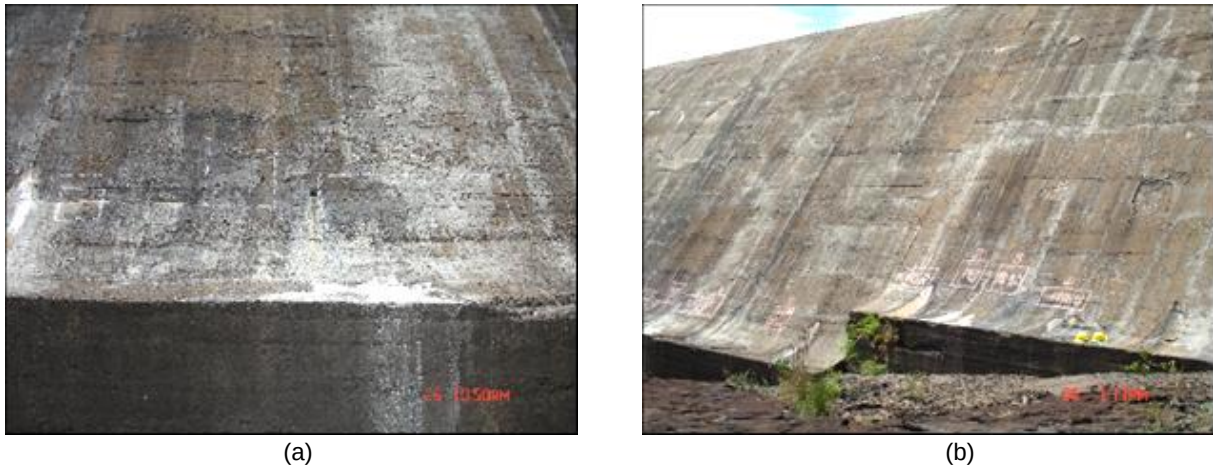
FIGURA 21 - LIMITAÇÃO DAS ÁREAS COM MANIFESTAÇÕES PATOLÓGICAS SUPERFICIAIS (A). IDENTIFICAÇÃO DAS ÁREAS E DO TIPO DE MR A SER APLICADO (B).
