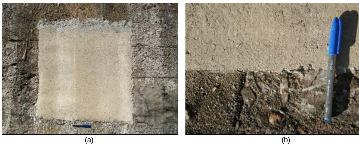
FIGURA 78 – PONTO DE APLICAÇÃO Nº. 4, MATERIAL DE REPARO: CONCRETO COM ADIÇÃO DE FIBRA COMERCIAL CORRUGADA DE PET (A). DETALHE DA BORDA DO MR E SUBSTRATO (B).
