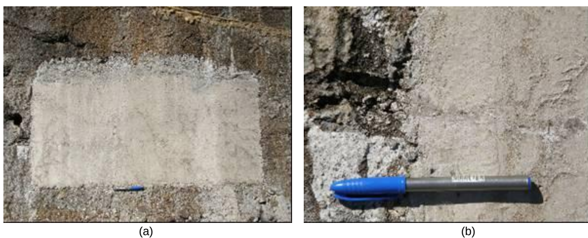
FIGURA 80 – PONTO DE APLICAÇÃO Nº. 6, MATERIAL DE REPARO: CONCRETO COM ADIÇÃO DE MATERIAL RECICLADO PNEU 5% (A). DETALHE DA BORDA DO MR E SUBSTRATO (B).
