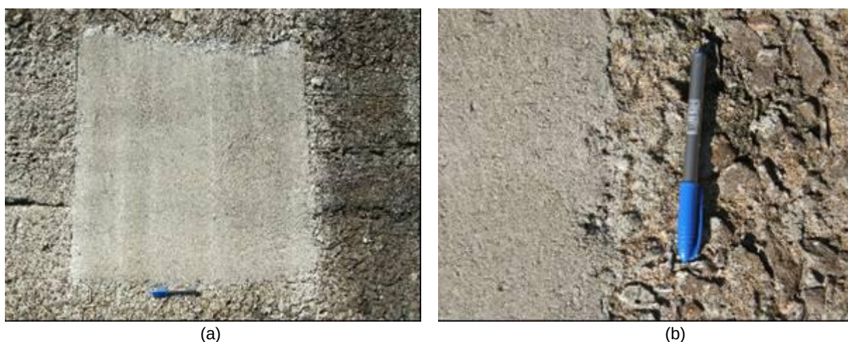
FIGURA 81 – PONTO DE APLICAÇÃO Nº. 7, MATERIAL DE REPARO: CONCRETO COM ADIÇÃO DE MATERIAL RECICLADO PEBD 2,5% (A). DETALHE DA BORDA DO MR E SUBSTRATO (B).
