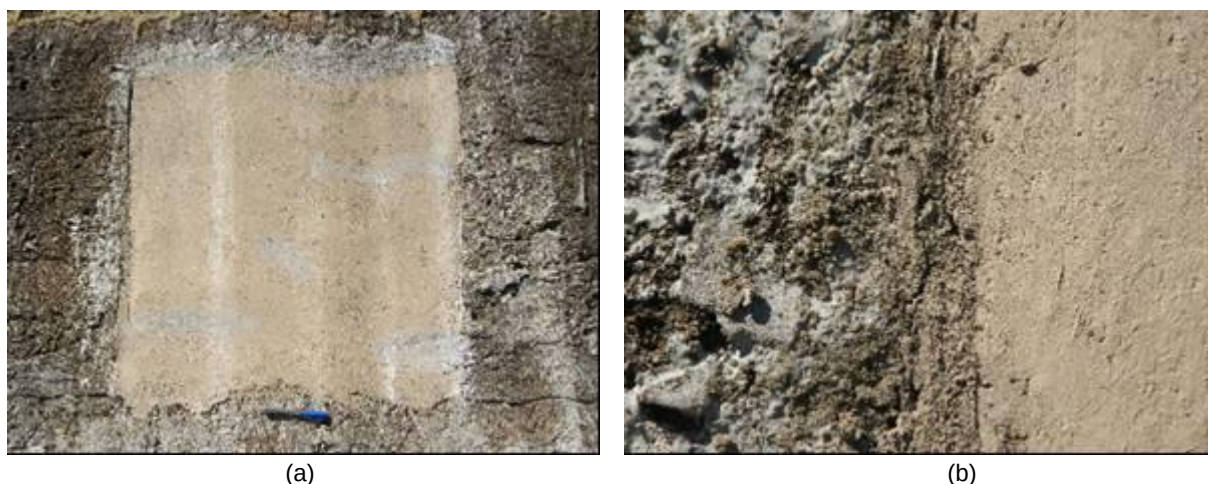
FIGURA 82 – PONTO DE APLICAÇÃO Nº. 8, MATERIAL DE REPARO: CONCRETO COM ADIÇÃO DE MATERIAL RECICLADO PET 2,5% (A). DETALHE DA BORDA DO MR E SUBSTRATO (B).
