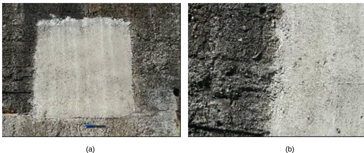
FIGURA 75 – PONTO DE APLICAÇÃO Nº. 1, MATERIAL DE REPARO: CONCRETO DE REFERÊNCIA SEM ADIÇÕES (A). DETALHE DA BORDA DO MR E SUBSTRATO (B).
