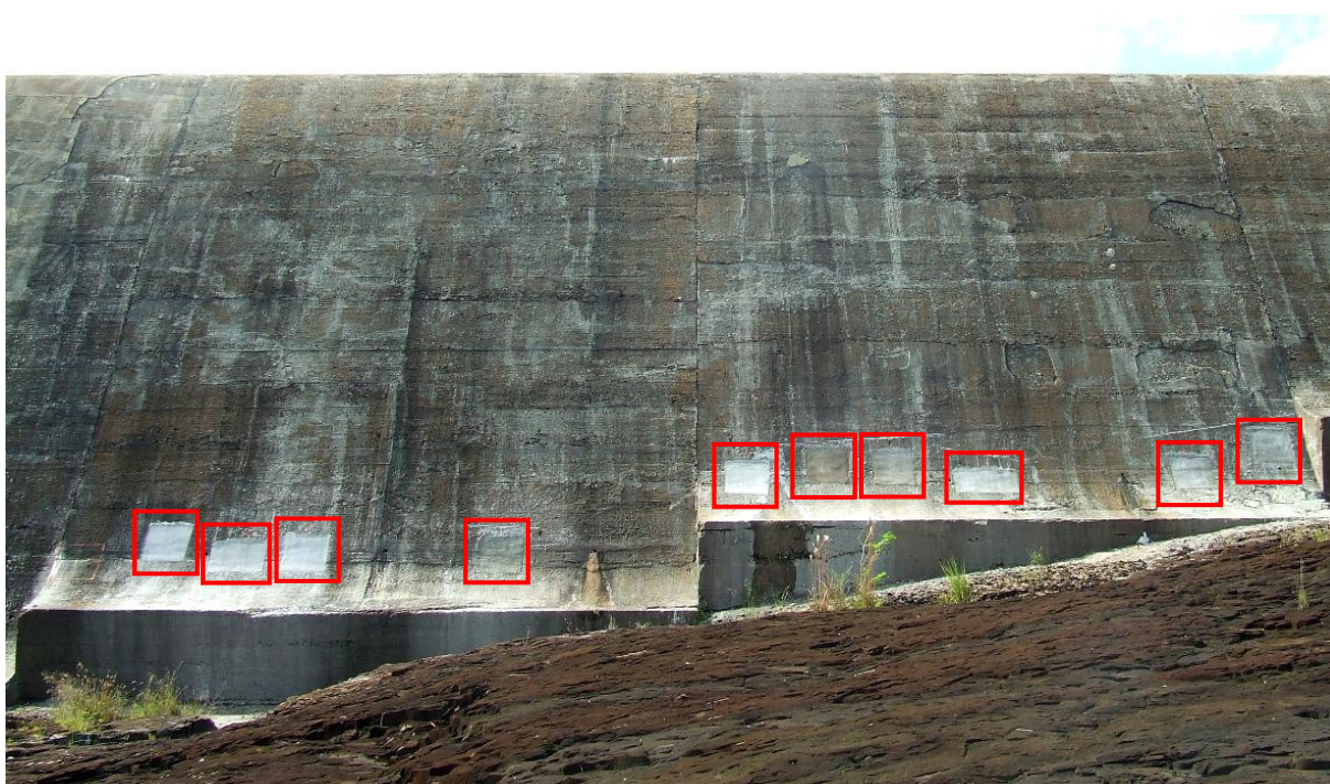
FIGURA 25 - VERTEDOIRO DA BARRAGEM DA UHE MOURÃO COM DESTAQUE NOS PONTOS DE APLICAÇÃO DOS MATERIAIS DE REPARO ESTUDADOS.
