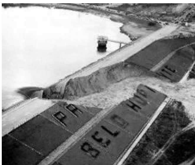
Figura 3. Rompimento da barragem da Pampulha em Belo Horizonte. 1
