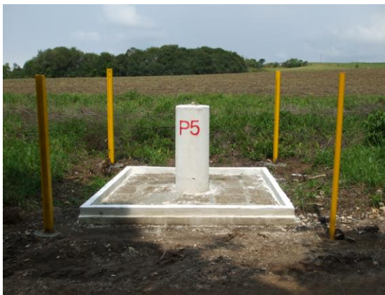
Figura 17 - Pilar P5 após recuperação FONTE: O autor
