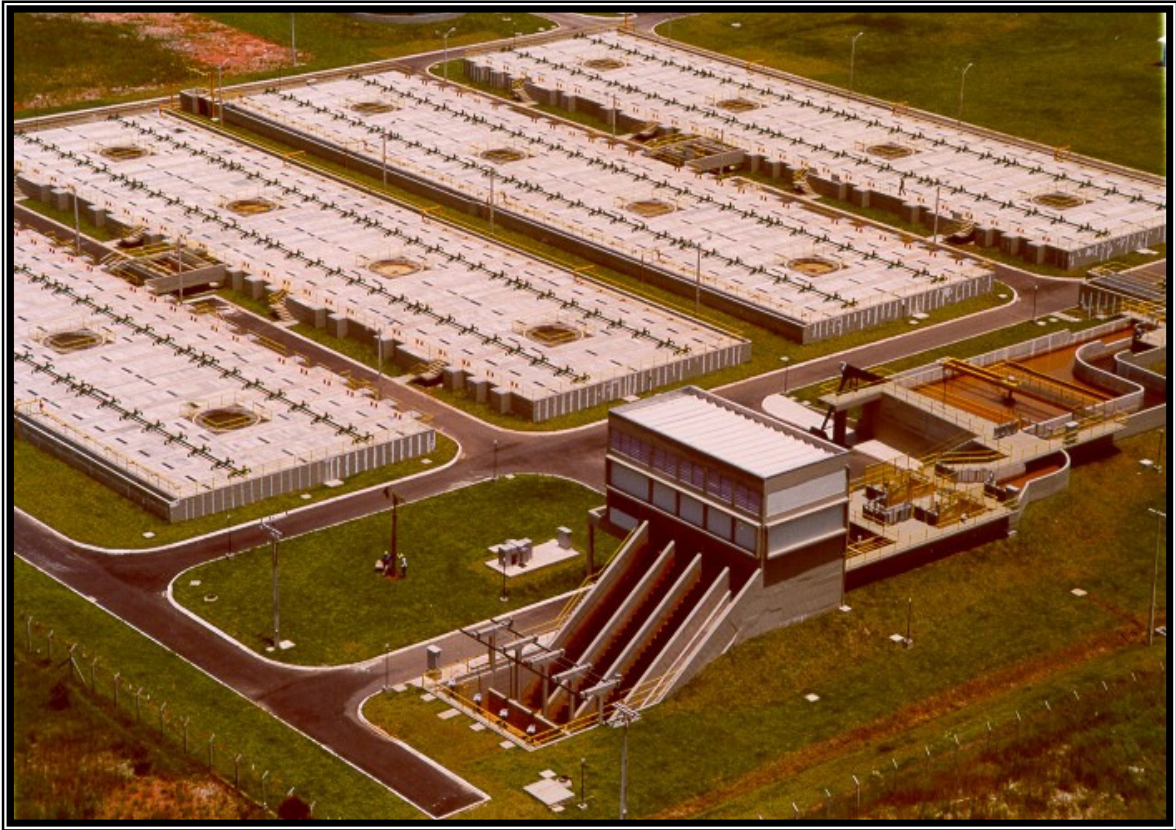
FIGURA 14 - VISTA GERAL DA ETE ATUBA SUL. FONTE: SANEPAR (1998)
