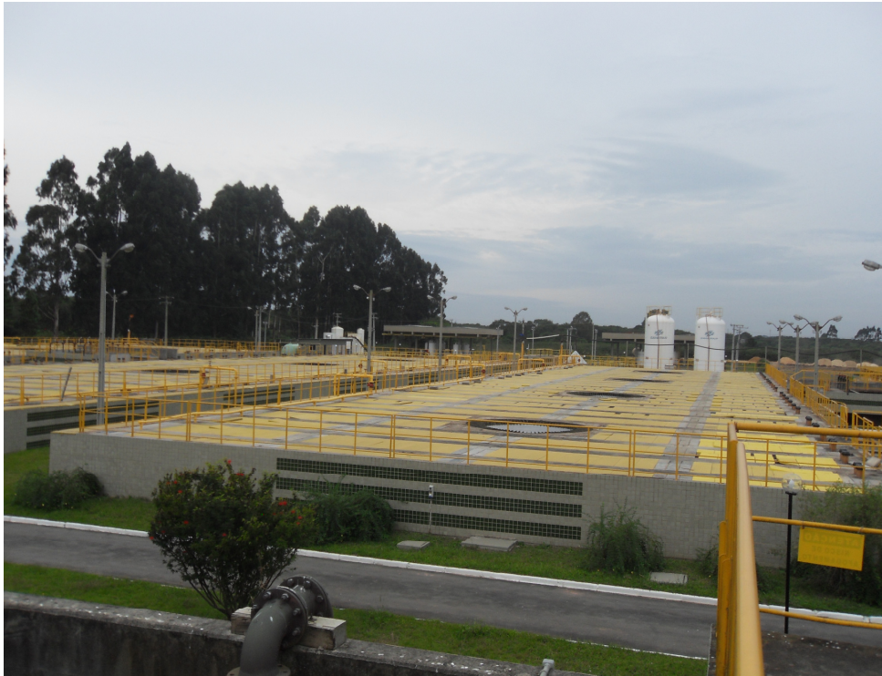
FIGURA 18 - VISTA DOS RALFS DA ETE ATUBA SUL
