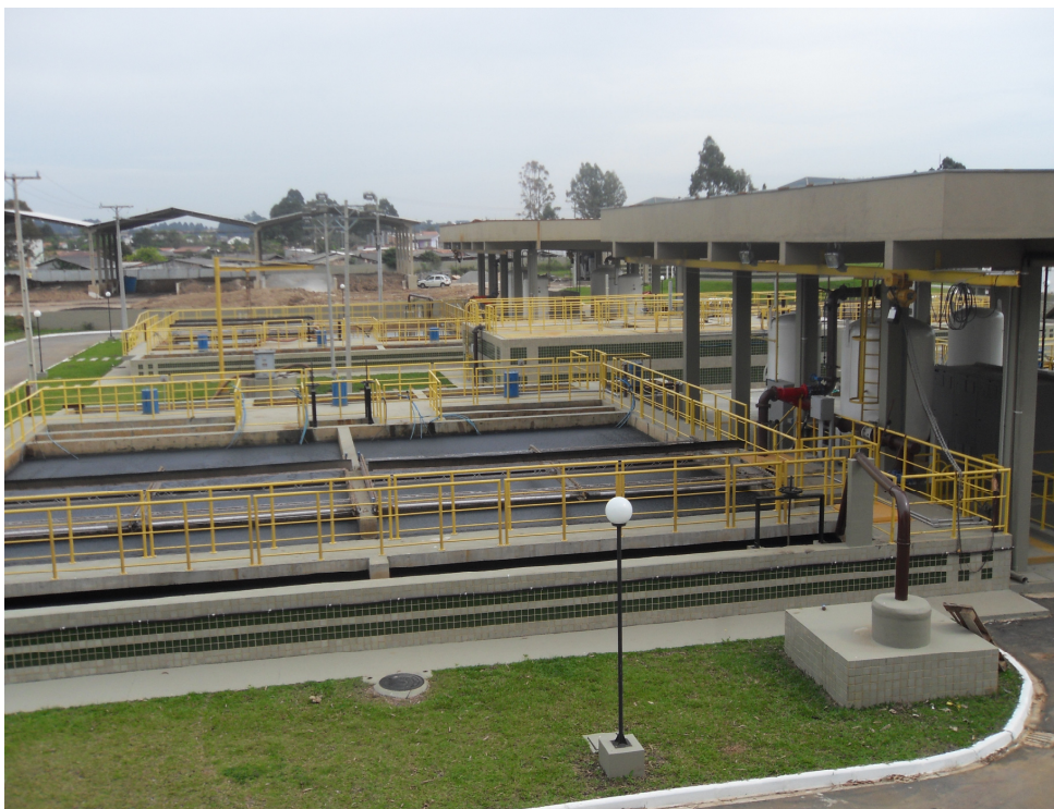
FIGURA 19 - VISTA DOS MÓDULOS DE FLOCO FLOTAÇÃO DA ETE ATUBA SUL
