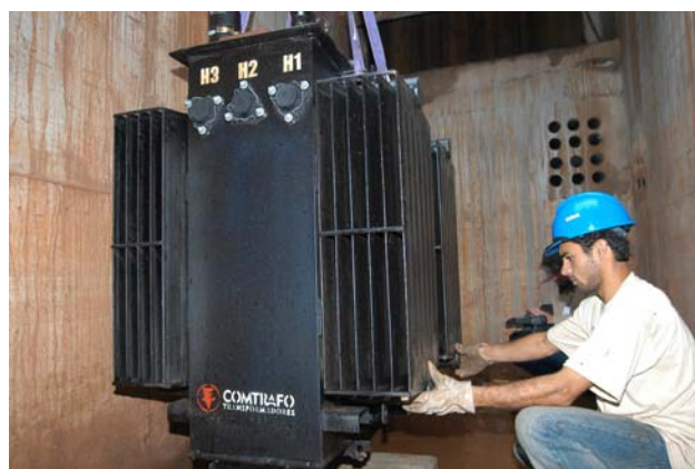
FIGURA 2.20 – INSTALAÇÃO DE TRANSFORMADOR SUBMERSÍVEL
