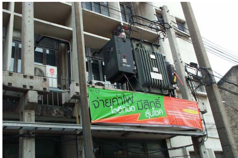
FIGURA 1.1 – TRANSFORMADOR SUBTERRÂNEO EM POSTE
