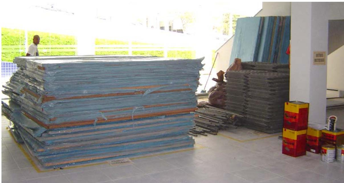
**FIGURA 4.16 – Materiais armazenados nos locais definidos por demarcação e placas**
