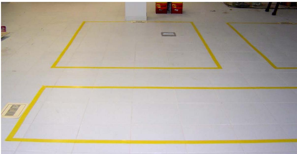
**FIGURA 4.15 – Demarcação horizontal para armazenamento de materiais**
