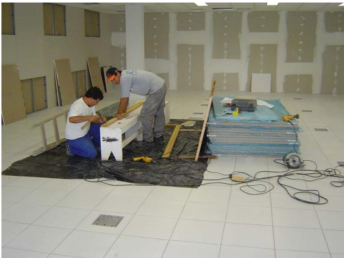
**FIGURA 4.11 – Disposição inicial dos materiais, próximos aos pontos de utilização**
