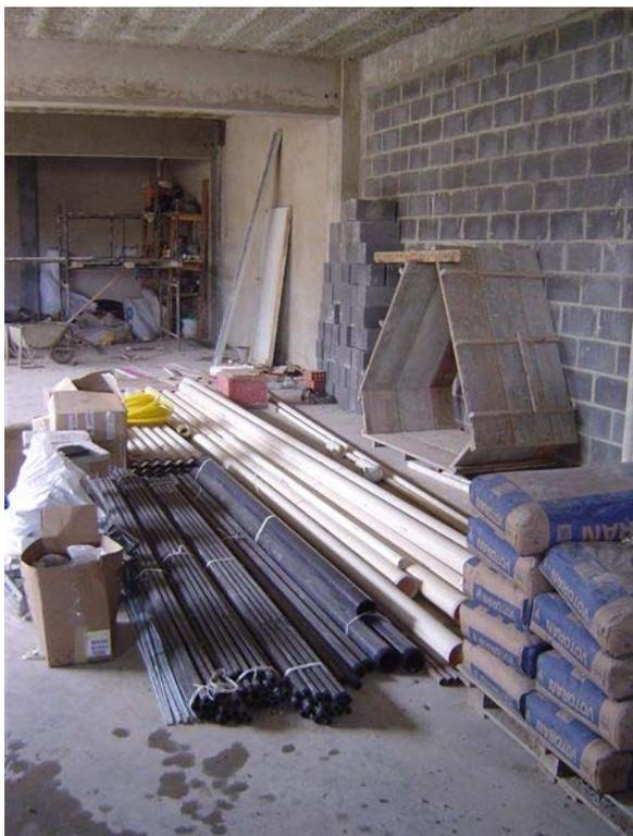
**FIGURA 4.3 – Estoque improvisado ao longo do canteiro**
