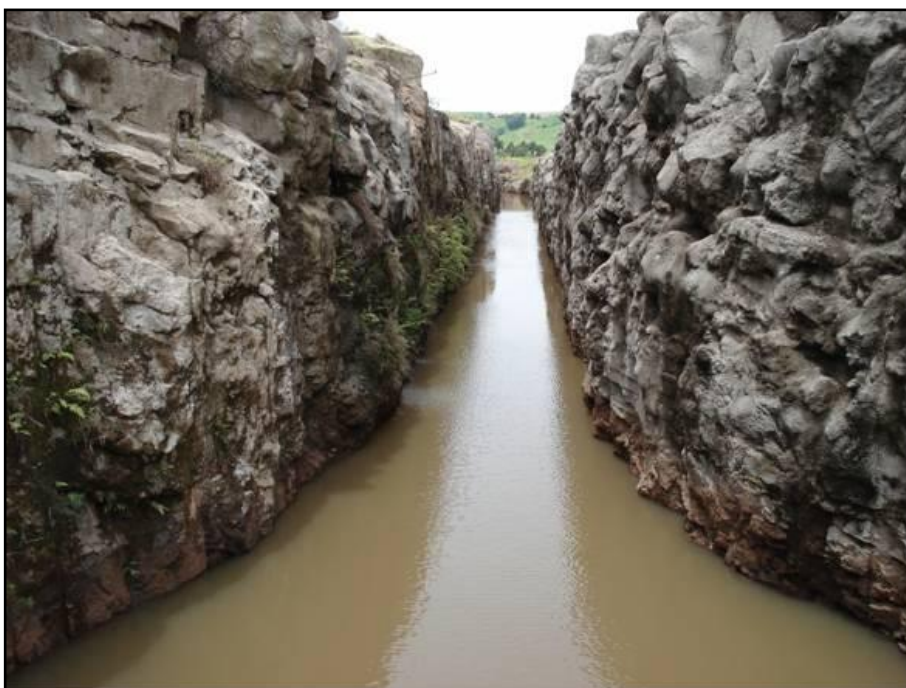
FIGURA 2: CANAL DE ADUÇÃO DO RESERVATÓRIO DA PCH DE SALTO NATAL, CAMPO MOURÃO, PARANÁ
