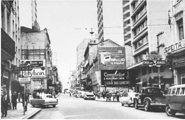
Figura 17 – Rua XV esquina com Rua Ébano Pereira (1965)
