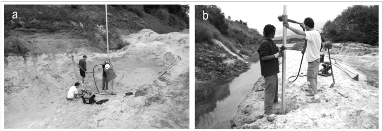
Figura 12: Preparação da sondagem com vibro-testemunhador, (a) pontos S01 e (b) S03, areal da Ilha III, região de Paranaguá.
