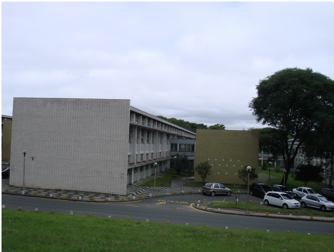
FIGURA 10 – PRÉDIOS DO BLOCO V DO CENTRO POLITÉCNICO FONTE: O AUTOR (2010)
