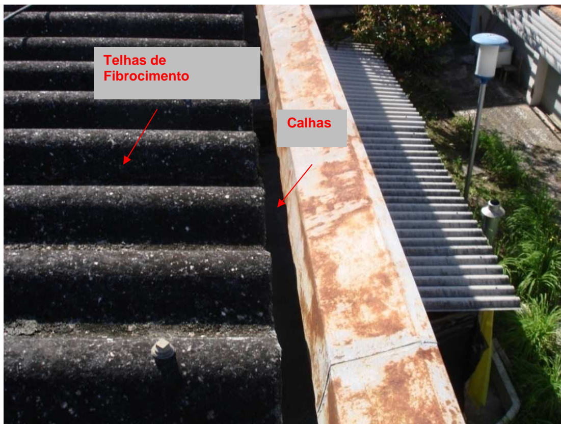
FIGURA 15 – COBERTURA E CALHAS DA EDIFICAÇÃO FONTE: O AUTOR (2010)
