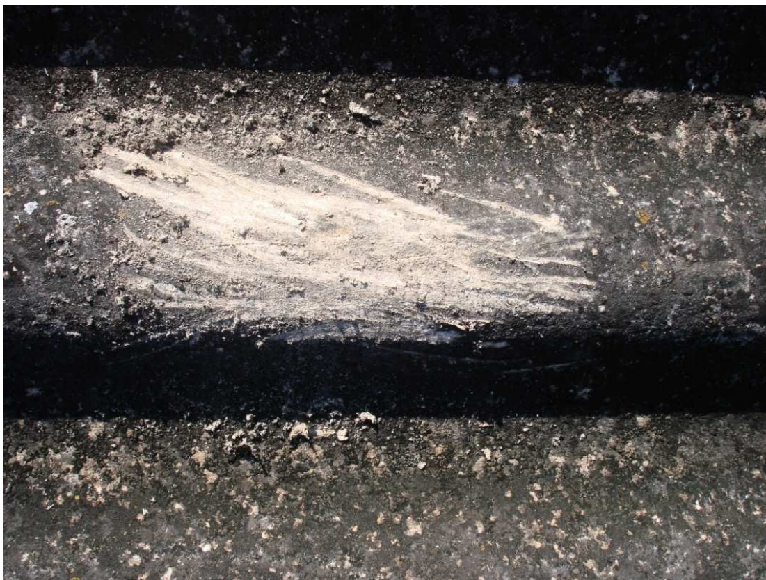
FIGURA 14 – DETALHE DA CROSTA EXISTENTE NA SUPERFÍCIE DE CAPTAÇÃO FONTE: O AUTOR (2010)
