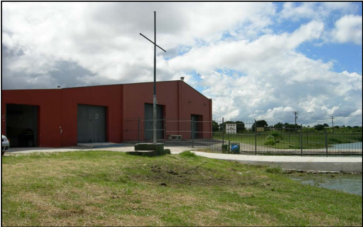
FIGURA 40 - Foto com estrutura para prática de esportes náuticos (garagem de barcos) Parque Iguçu, Curitiba – PR. FONTE: O autor (2009).
