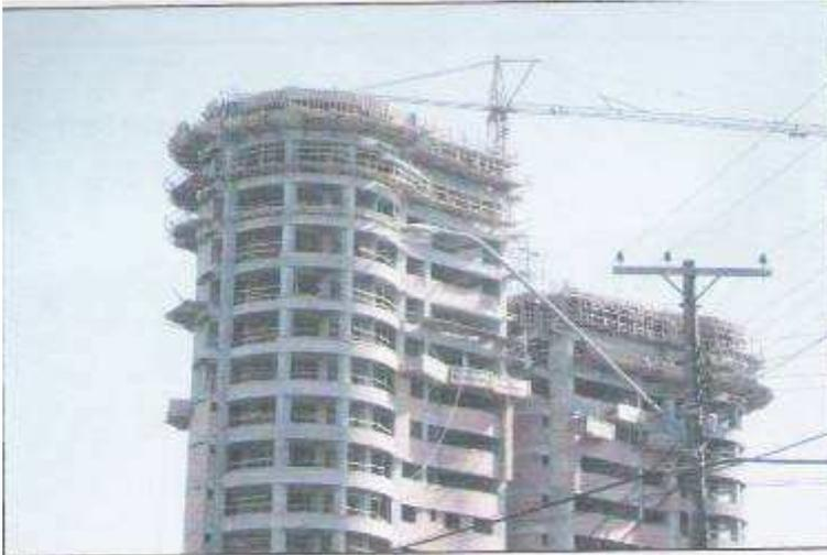
FIGURA 4 – UTILIZAÇÃO DE GRUAS PARA O TRANSPORTE DE MATERIAIS (PRINCÍPIO 4)
