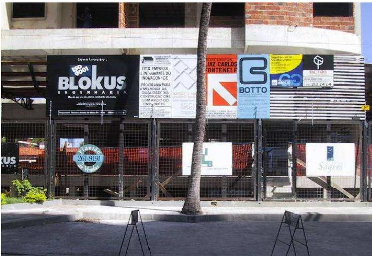
FIGURA 7 – ADOÇÃO DE PLACAS PARA INDICAR A SITUAÇÃO DA OBRA (PRINCÍPIO 7)
