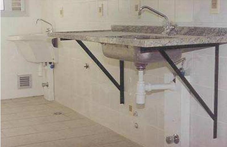
FIGURA 5 – UTILIZAÇÃO DE MATERIAIS PRÉ-FABRICADOS (PRINCÍPIO 5)
