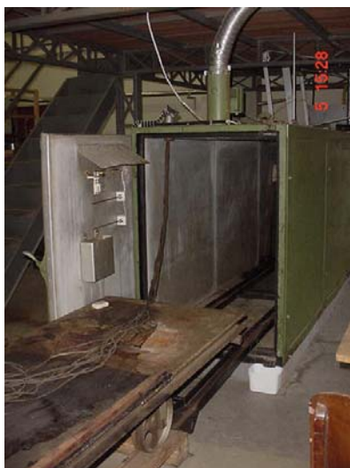
FIGURA 28 – DETALHE DA CÂMARA DE CLIMATIZAÇÃO
