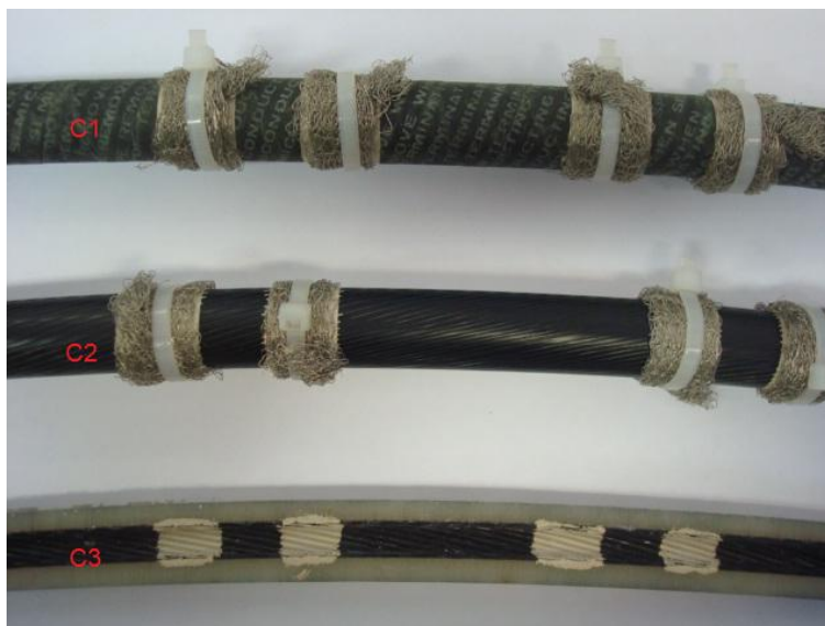
FIGURA 17 – FOTO DOS CABOS MOSTRANDO A PINTURA PRATEADA CONDUTORA E A LIGAÇÃO DOS ELETRODOS.
