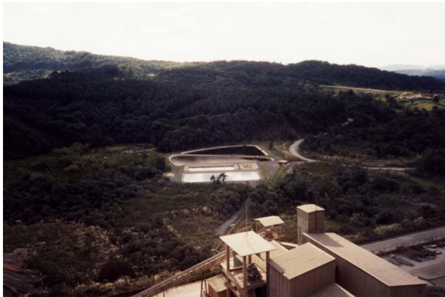
ANEXO 28: VISTA DA FACE NOROESTE DA FÁBRICA DE CIMENTO.
