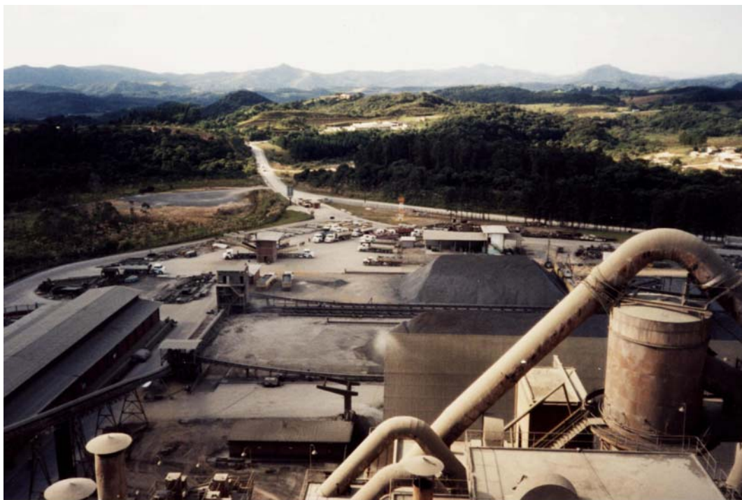
ANEXO 26: VISTA DA FACE NORTE DA FÁBRICA DE CIMENTO.
