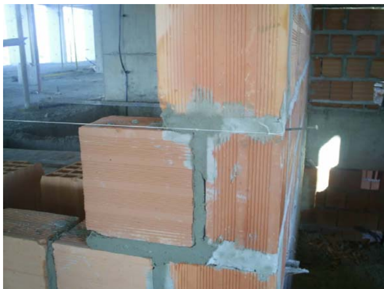
FIGURA 8 – ALINHAMENTO COM FIO DE NÁILON FONTE: A autora (2009)
