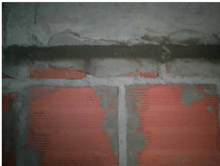
FIGURA 10 – MASSA EXPANSORA APLICADA FONTE: A autora (2009)
