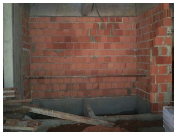
FIGURA 7 – FECHAMENTO DA ALVENARIA DO POÇO DO ELEVADOR FONTE: A autora (2009)
