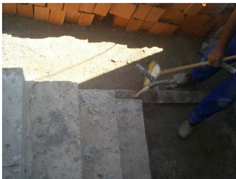
FIGURA 5 – LIMPEZA DO LOCAL ANTES DO INÍCIO DO PROCESSO FONTE: A autora (2009)
