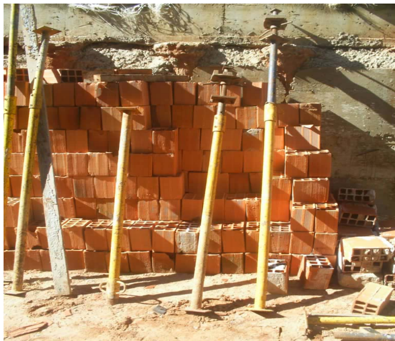
FIGURA 2 – ARMAZENAMENTO DE BLOCOS DE SEIS FUROS FONTE: A autora (2009)
