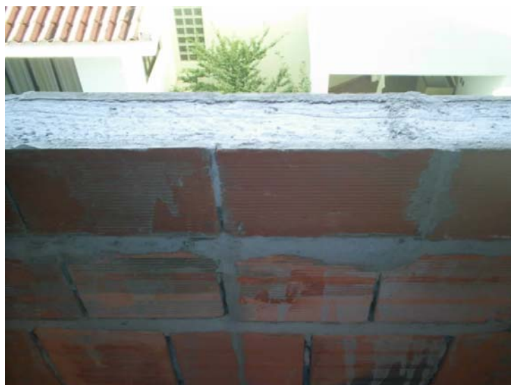
FIGURA 9 – CONTRAVERGA (COCHO DE CONCRETO) FONTE: A autora (2009)
