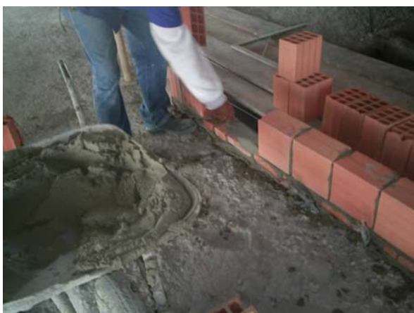
FIGURA 6 – ASSENTAMENTO DA PRIMEIRA FIADA FONTE: A autora (2009)
