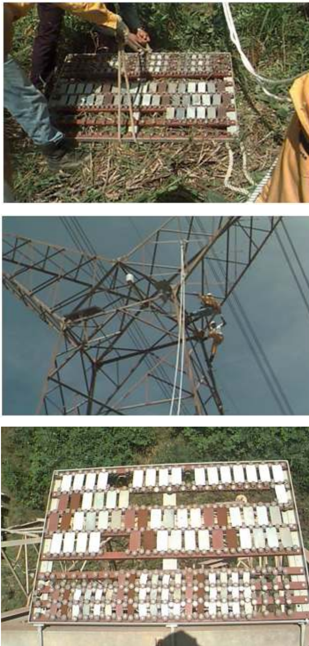
FIGURA 19. INSTALAÇÃO DOS COLETORES DE POLUENTES E DO PAINEL DE INTEMPERISMO NATURAL EM TORRE DE TRANSMISSÃO DA LT 702 DE SÃO LUÍS.
