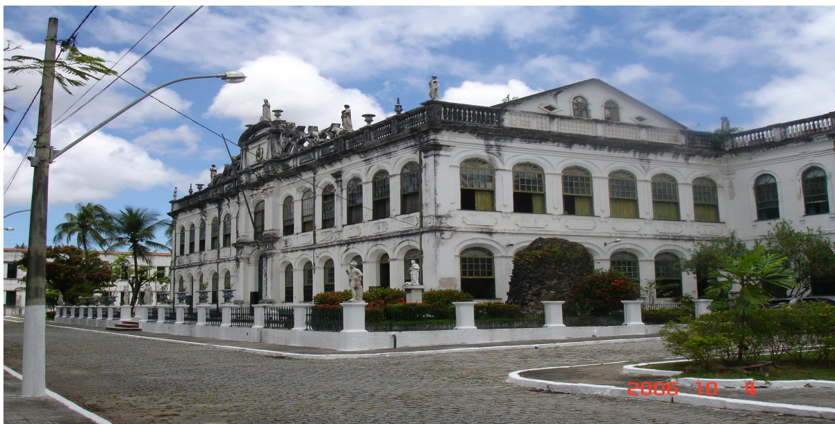
Figura nº 21 – Abrigo Dom Pedro II – Projeto de restauração patrimônio Fonte - Gerar
