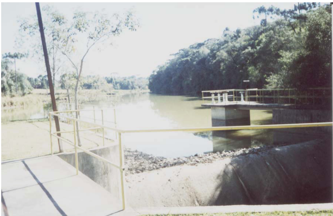
FIGURA 13 - FOTOGRAFIA DA PRINCIPAL REPRESA DE CAPTAÇÃO DE ÁGUA PELA SANEPAR - LAPA - PR - 2002
