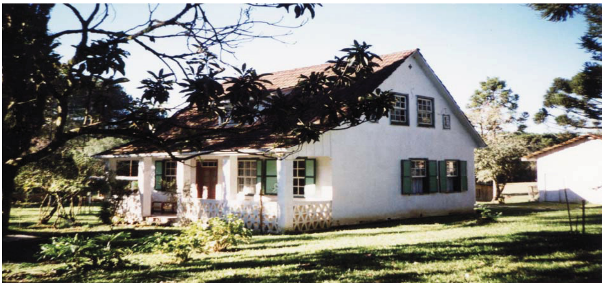
FIGURA 3 - FOTOGRAFIA DA SEDE DA CHÁCARA, HOTEL FAZENDA TIA LEKA, NA BACIA DO RIBEIRÃO CALIXTO, CASA CENTENÁRIA EM ARQUITETURA PORTUGUESA - LAPA - PR - 2002
