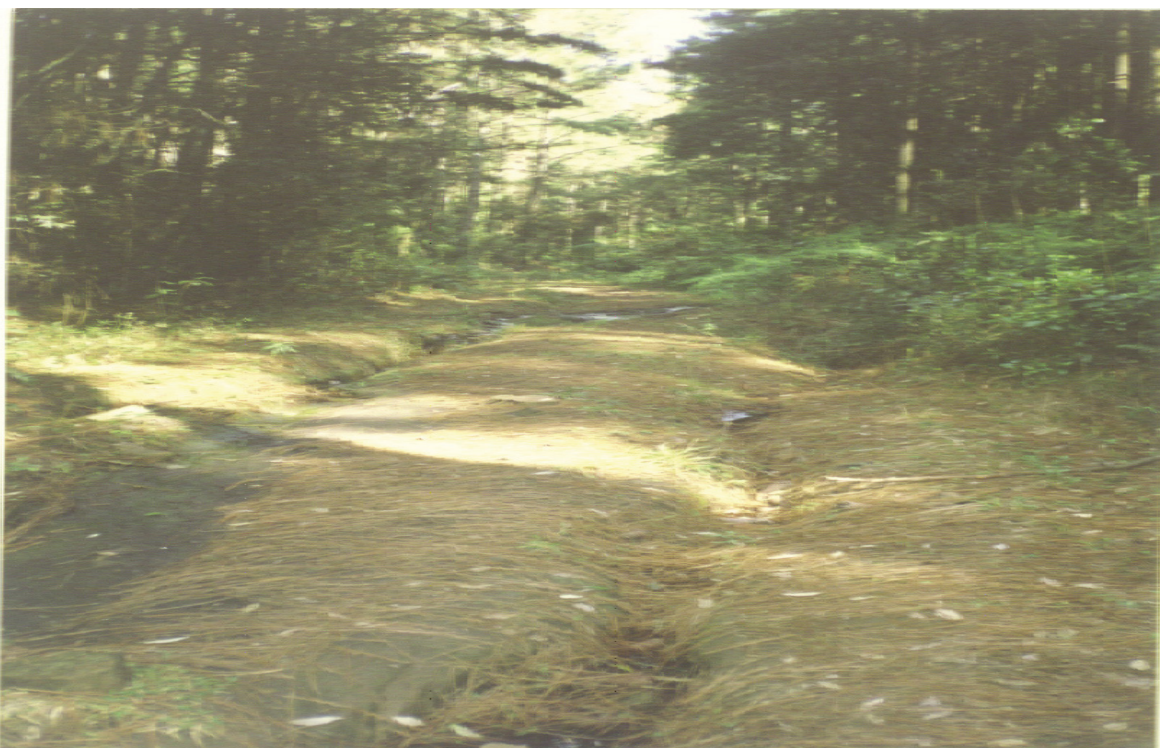
FIGURA 11 - FOTOGRAFIA DA ESTRADA INTERNA DO PARQUE DO MONGE, COM EROSÃO - LAPA - PR - 2002
