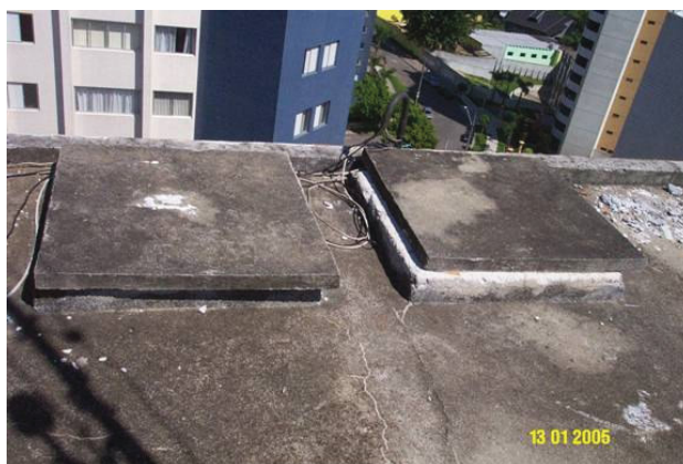
FIGURA 4.15 – TAMPA DE ACESSO DO RESERVATÓRIO SUPERIOR
