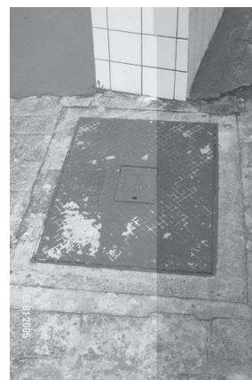
b) Caixa subterrânea para hidrômetro padrão SANEPAR
