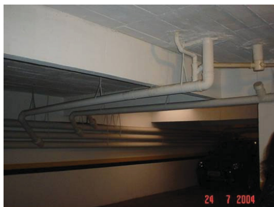
FIGURA 4.18 – SUB-COLETORES DE ESGOTO SANITÁRIO DO EDIFÍCIO
