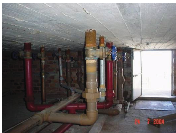
FIGURA 4.16 – BARRILETE DE DISTRIBUIÇÃO
