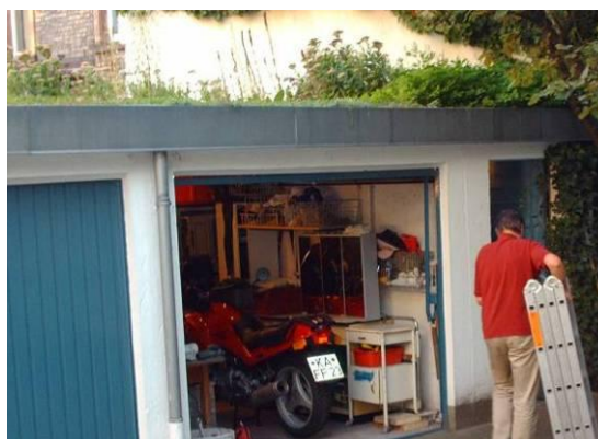
Figura 95 – CV extensiva sobre garagens Fonte: A autora (2006)
