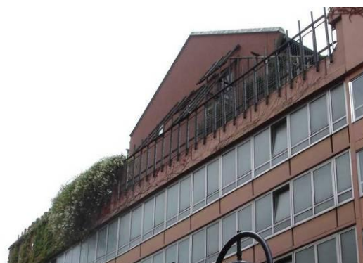
Figura 104 – Vista da fachada do prédio Fonte: A autora (2006)
