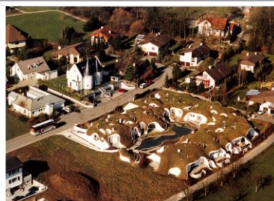
Figura 85 – Nine Houses - Vista aérea Fonte: Greenroofs (2006)
