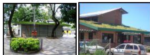
Figura 75 – Telhados instalados - Central do Brasil - Rio de Janeiro; - Posto Policial - Santa Catarina Fonte: ECOTELHADO (2008)
