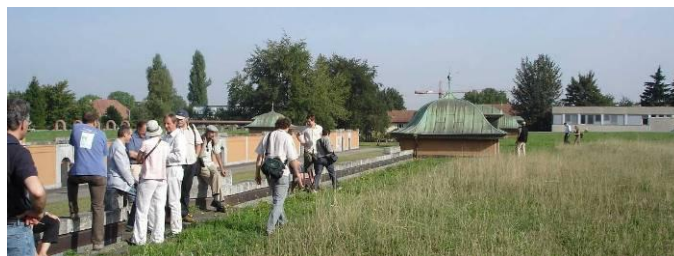
Figura 81 – CV extensiva sobre os reservatórios da estação de Moos - Zurique Fonte: A autora (2006)
