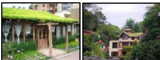
Figura 74 – Telhados instalados - Rio Grande do Sul Fonte: ECOTELHADO (2008)
