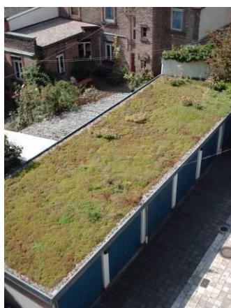
Figura 95 – CV extensiva sobre garagens Fonte: A autora (2006)
