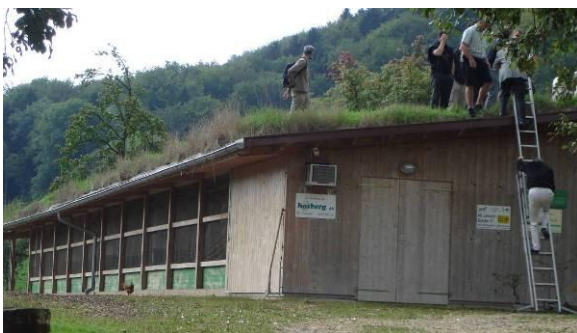
Figura 86 – CV “rústica” sobre o galpão do aviário orgânico em Asphof Fonte: A autora (2006)
