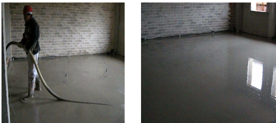
Figura 1.2 – Execução do contrapiso com argamassa auto-nivelante
