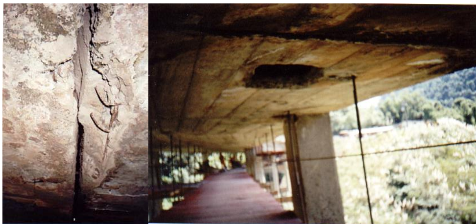
FIGURA 12 - FOTO VISTA INFERIOR DAS JUNTAS GERBER
