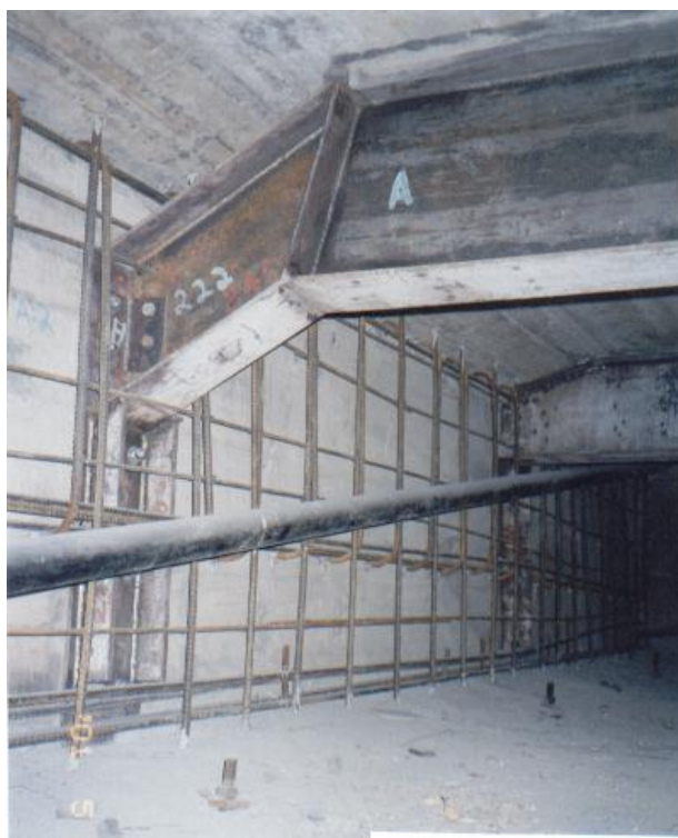
FIGURA 15 - FOTO VIGAS METÁLICAS E ARMADURA DE REFORÇO DAS LONGARINAS – DETALHE PROTENSÃO EXTERNA DEVIDO AO VEÍCULO DE ITAIPU
