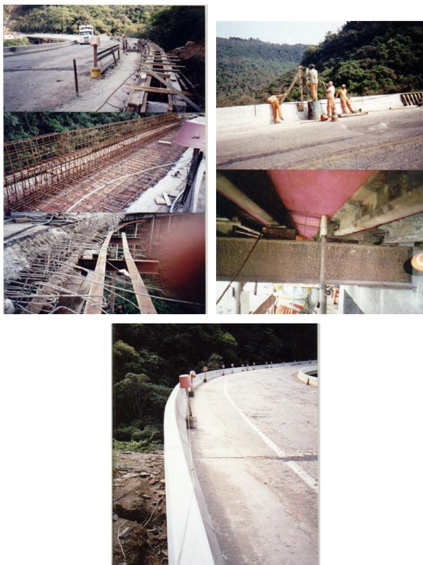
FIGURA 23 - FOTO SEQÜÊNCIA CONSTRUTIVA DEFENSAS
