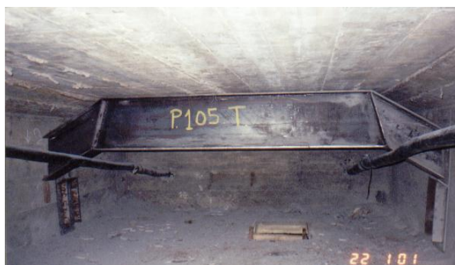
FIGURA 16 - FOTO PROJETO DE VIGAS METÁLICAS EMPREGADAS
