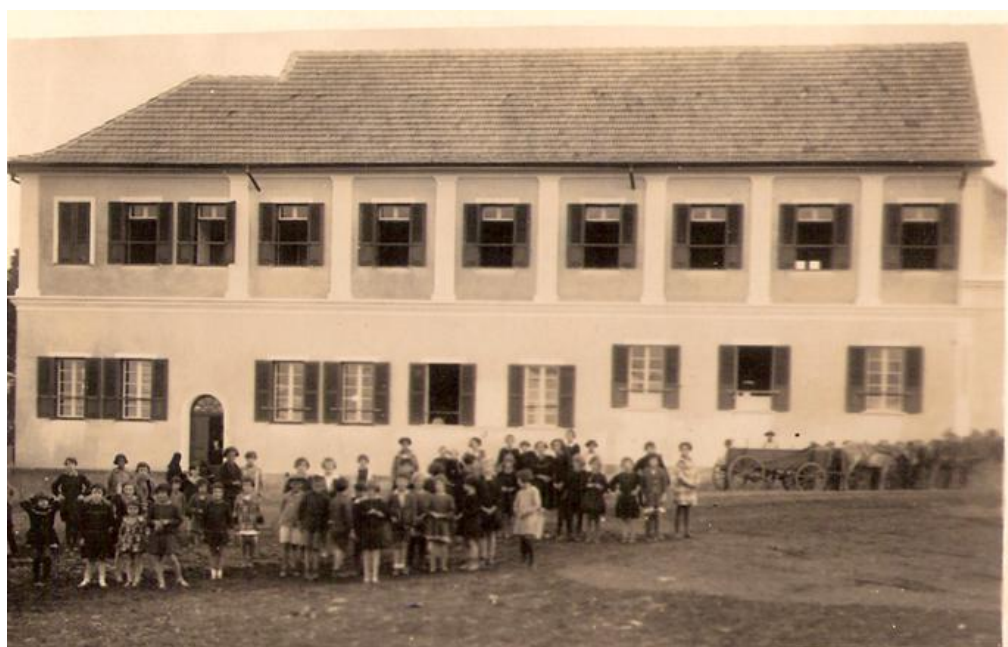
Segunda construção de dois andares ao longo do pátio interno, 1929. (Acervo de Mariinha Macedo, Casa Emília Erichsen, Castro)
