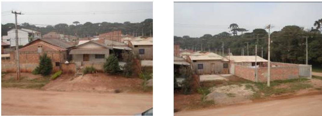
FIGURA 14 - Entorno do loteamento, ainda sem pavimentação
