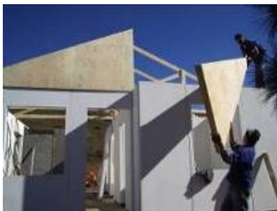
Etapa 3 – Montagem das tesouras
