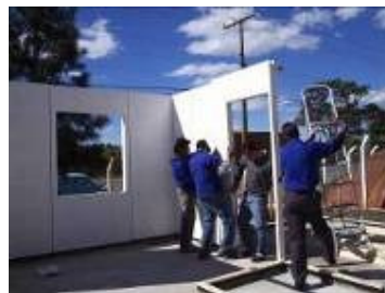
Etapa 2 – montagem dos painéis externos
