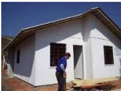
Etapa 5 – Construção finalizada
