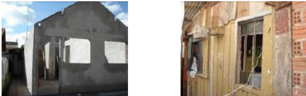
FIGURA 17 - Moradia em construção à esquerda. Casa provisória à direita
