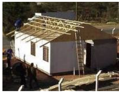
Etapa 4 – Preparação para colocação das telhas de fibrocimento
