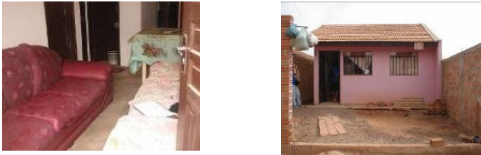
FIGURA 16 - Sala sem acabamento do piso e fachada da residência analisada
