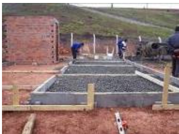
Etapa 1 – Detalhe do banheiro em alvenaria e das vigas em concreto
