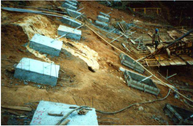
Figura 3.7 - Ancoragem executada abaixo da plataforma dos oleodutos (a) Placas concretadas e ancoradas no solo (b) Placas concretadas unidas por concreto projetado FONTE: PETROBRAS (1997)
