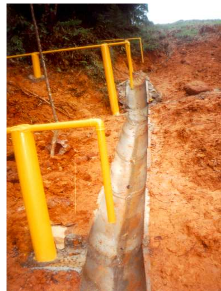
Figura 3.8 - Dispositivos de drenagem (a) Canaleta de concreto de seção trapezoidal, que constitui a drenagem superficial da encosta (b) Extremidade dos drenos sub-horizontais profundos FONTE: PETROBRAS (1997)
