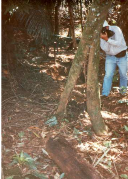
Figura 3.3 - Árvore situada a meia encosta, entre o oleoduto e o muro rompido, seccionada longitudinalmente pelo movimento da massa coluvionar FONTE: PETROBRAS (1997)
