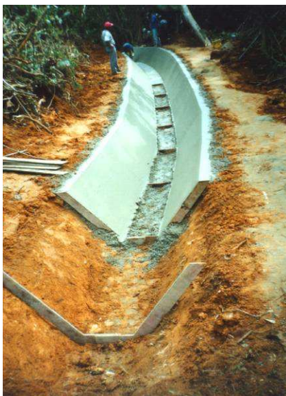
Figura 3.8 - Dispositivos de drenagem (a) Canaleta de concreto de seção trapezoidal, que constitui a drenagem superficial da encosta (b) Extremidade dos drenos sub-horizontais profundos FONTE: PETROBRAS (1997)
