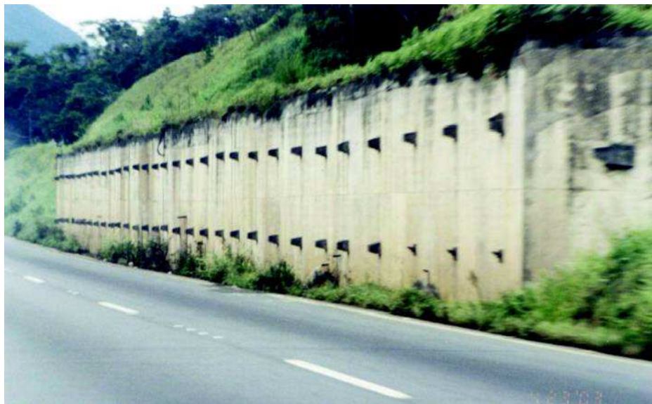
Figura 3.6 - Cortina atirantada atual construída no pé do colúvio FONTE: ANDRIONI (2005)
