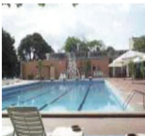
Figura 2-7. Piscina aquecida com os painéis solares AMG
