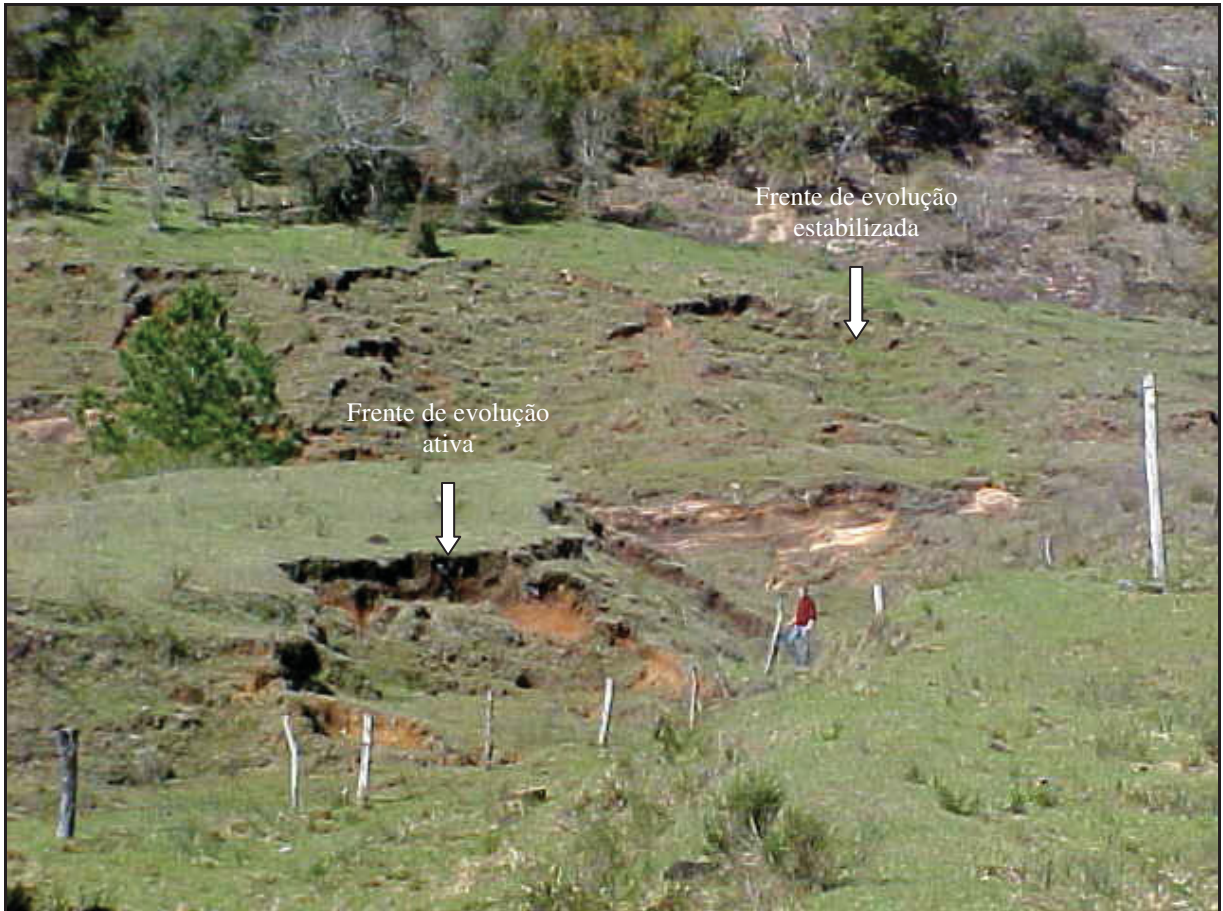
FIGURA 23 – Erosão complexa de grande porte
