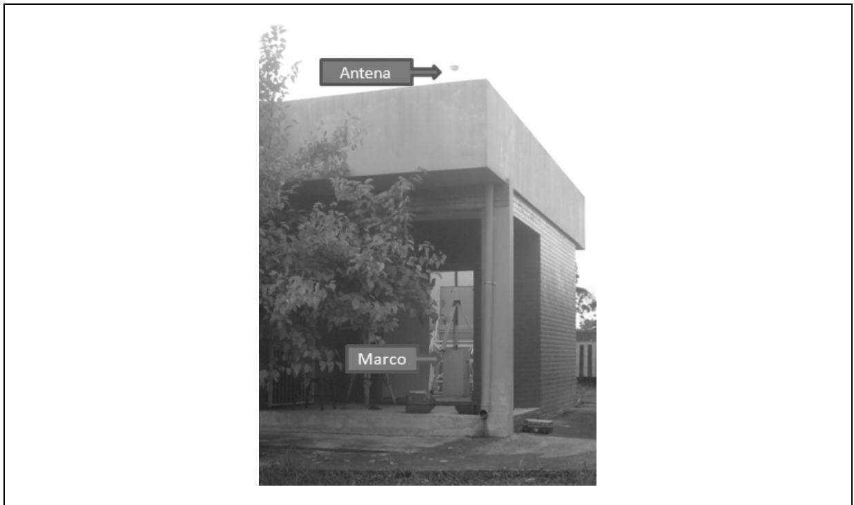
FIGURA 27 – RASTREIO COM O TELHADO ABERTO FONTE: A autora (2009)
