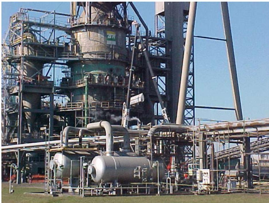
FIGURA 3 - UNIDADE DE EXTRAÇÃO DO ÓLEO DE XISTO (RETORTA). FONTE: GENENA, S. K. (2004).
