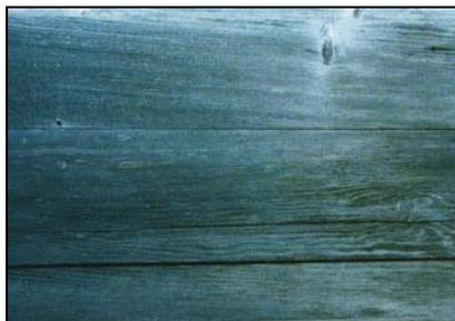
FIGURA 18 – DEGRADAÇÃO FÍSICA DA MADEIRA, FENÔMENO *WEATHERING*
