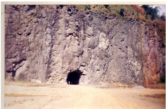
FOTO 10 – ABERTURA DO TÚNEL Autor: RIBEIRO, 1995
