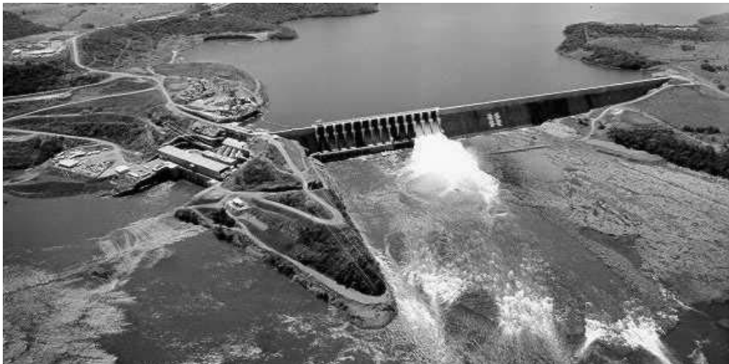
Figura 15 – Vista aérea da Usina Hidrelétrica de Salto Caxias (fonte: COPEL)
