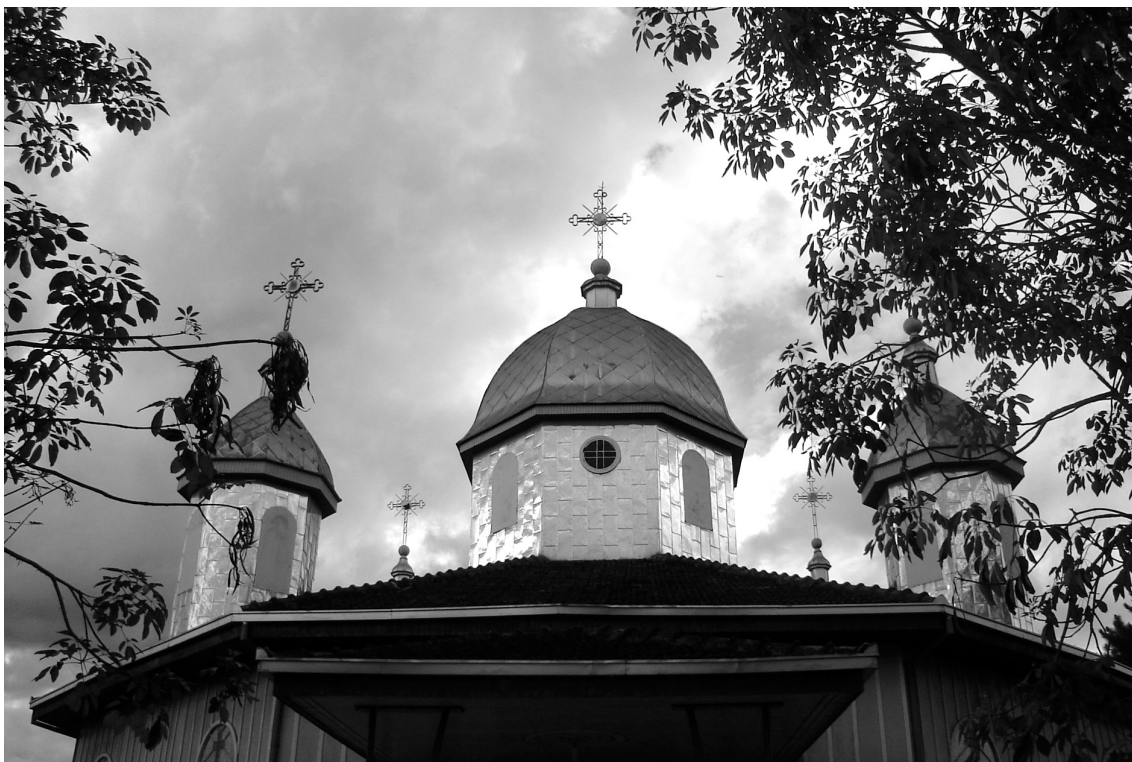
Fig. 2.8 - Cúpula metálica da Igreja da Transfiguração do Senhor, Linha Paraná, Prudentópolis (Acervo pessoal, autoria própria)
