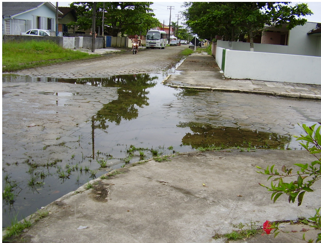
FIGURA 16 - ALAGAMENTOS EM RUAS CENTRAIS
