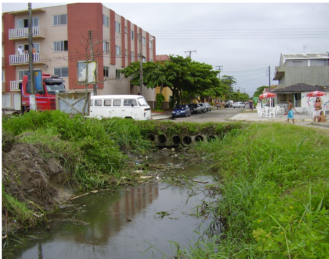
FIGURA 19 - DEPOSIÇÃO DE DEJETOS E LIXO EM ÁREA CENTRAL PRÓXIMA À ORLA
