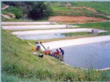
Vinimanta para revestimento de reservatório de água.
