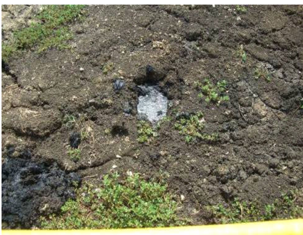
Figura 7. Aproximação da cobertura da lagoa da unidade de produtos cárneos.
