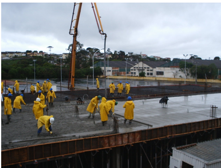
FIG. 5.14 – CONCRETAGEM DA LAJE – DETALHE DA BOMBA
