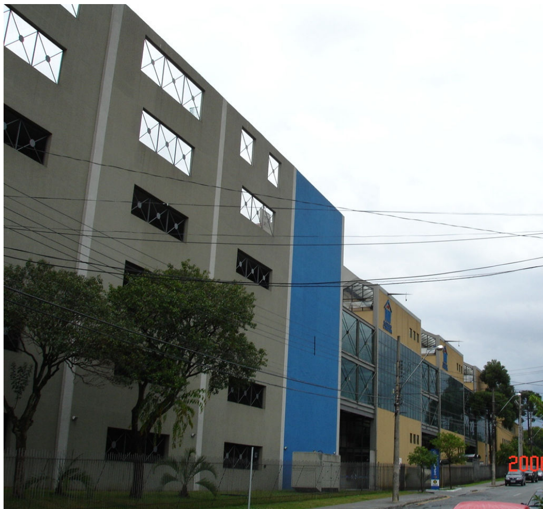
FIG. 5.8 – IMAGEM DA EDIFICAÇÃO CONCLUÍDA (FACHADA LATERAL) – FACULDADES CURITIBA
