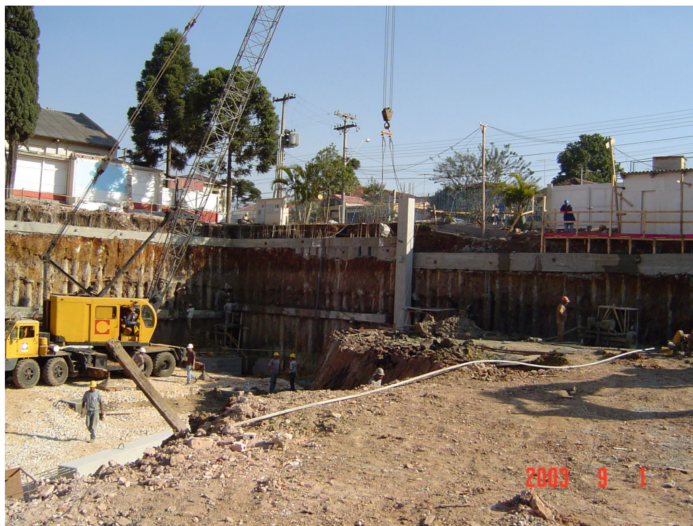
FIG. 5.5 – INÍCIO DAS ATIVIDADES DE MONTAGEM DA ESTRUTURA – FACULDADES CURITIBA
