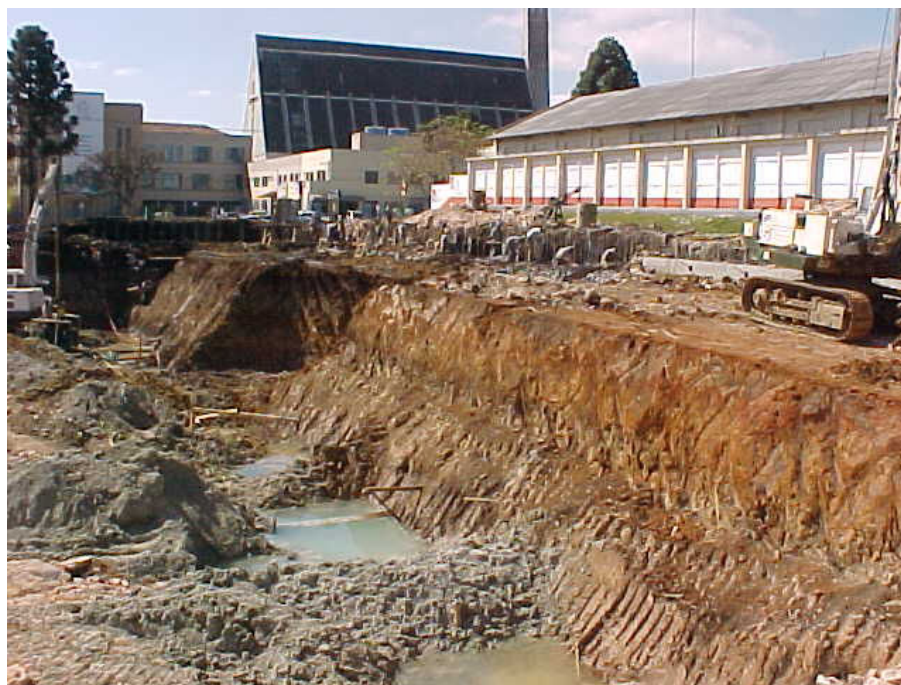
FIG. 5.4 – EDIFICAÇÃO EM CONSTRUÇÃO – TERRAPLANAGEM
