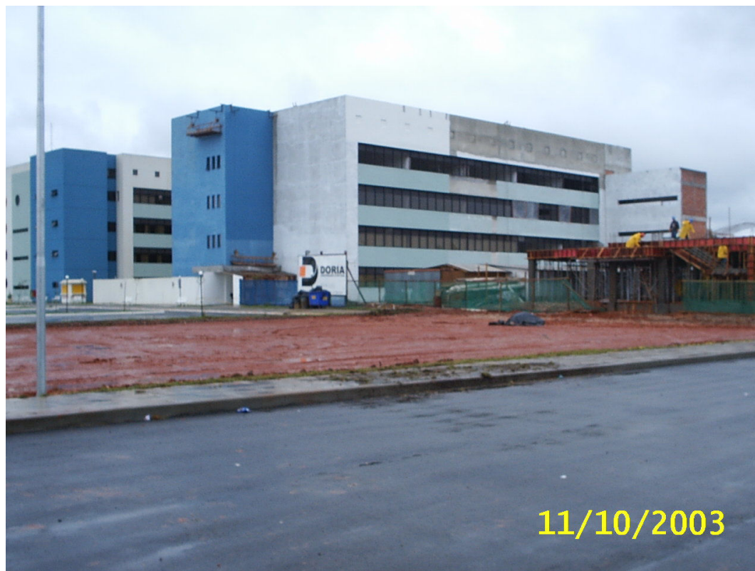
FIG. 5.16 – BLOCO ACABADO E EM CONSTRUÇÃO
