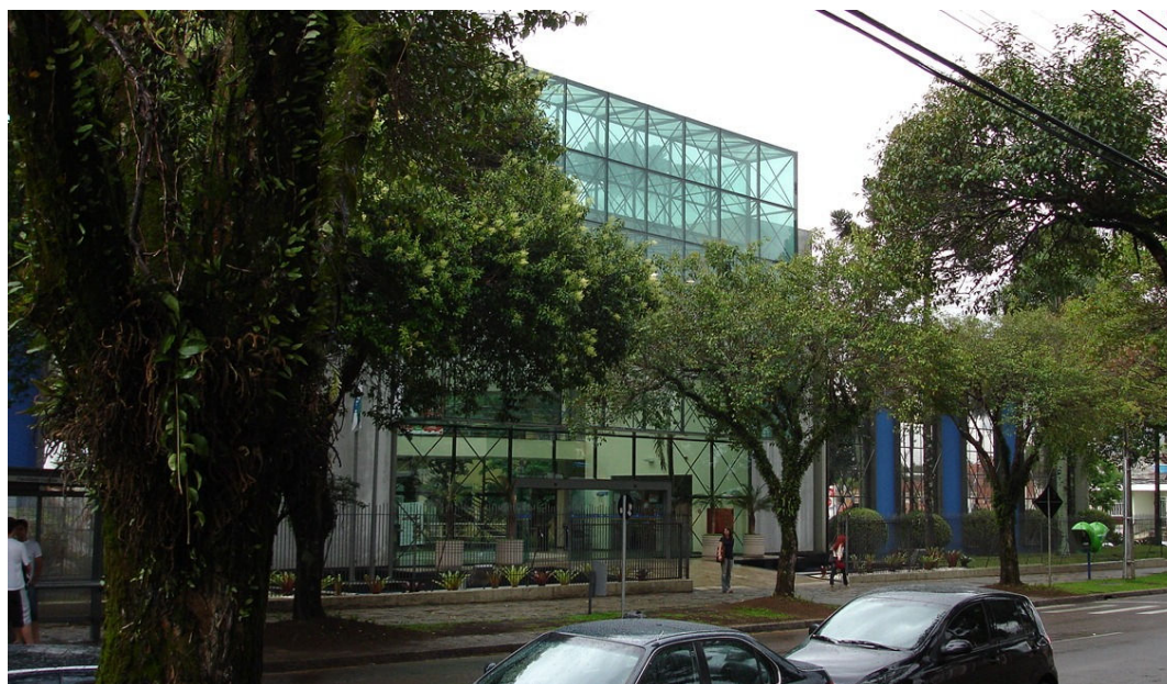
FIG. 5.7 – IMAGEM DA EDIFICAÇÃO CONCLUÍDA (FACHADA FRONTAL) – FACULDADES CURITIBA
