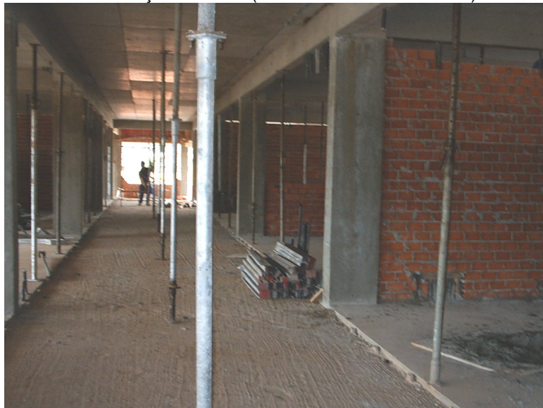
FIG. 5.13 – EXECUÇÃO DA LAJE (FORMAS E ESCORAMENTO)
