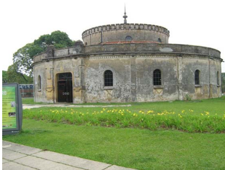
Fachada atual do Teatro do Paiol Bairro Rebouças – Curitiba (PR)
