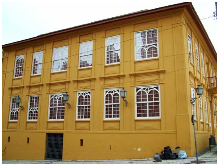
Palacete Wolff, antiga sede da Fundação Cultural de Curitiba Largo da Ordem – Centro de Curitiba
