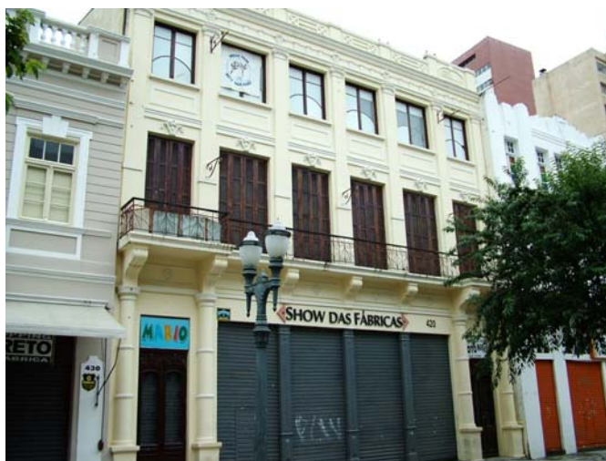
Fachada da antiga Galeria Schaffer onde se localizava o Cine Groff Calçada da Rua XV – Centro de Curitiba
