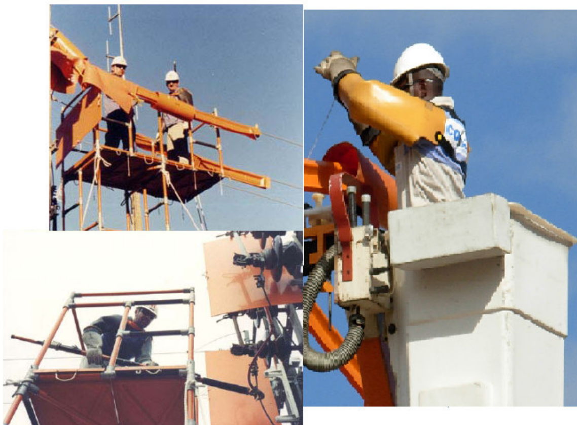
Figura 10 – Trabalhadores em manutenção de redes de linha viva.
