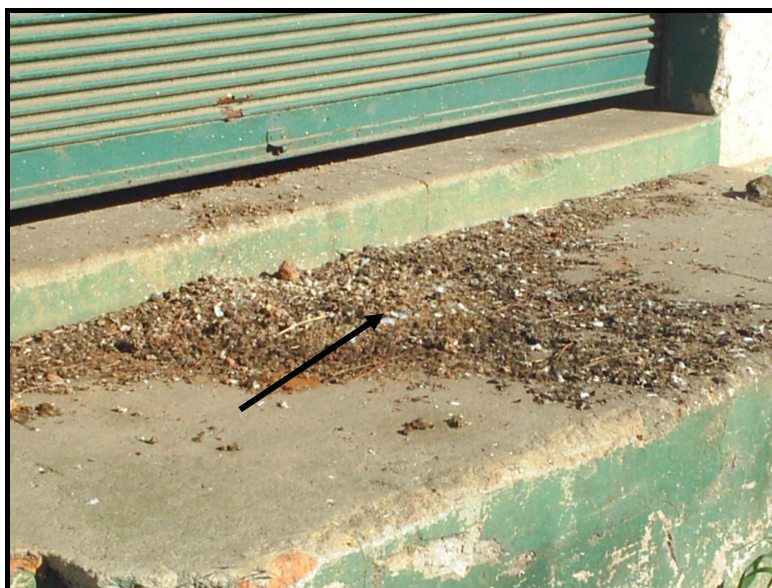
FIGURA 2 - MOSTRA ESCADA DO PRÉDIO DESATIVADO DO CEASA, ESTE LOCAL FOI POSITIVO PARA ISOLAMENTO DA AMOSTRA 57
