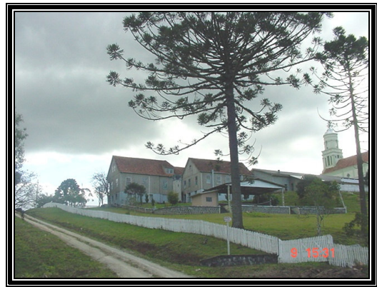
IMAGEM 09 – Imagem dos fundos do Colégio, ao lado da Igreja. Fonte: FOETSCH, 2006.
