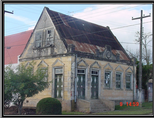
IMAGEM 24 – Antiga construção, datada de 1928. Fonte: FOETSCH, 2006.
