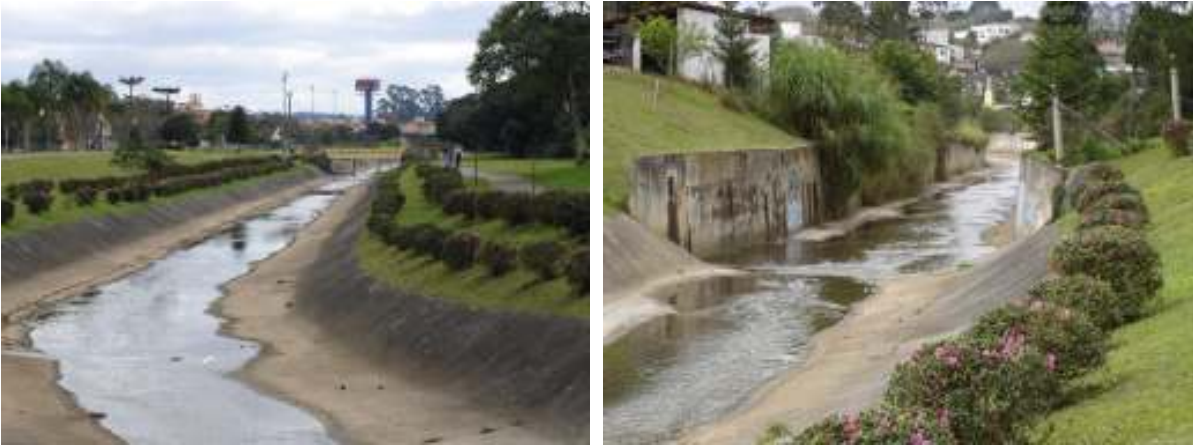
A) Retificação do rio Bacacheri, visão à montante e visão à jusante; a impermeabilização da calha do rio impede o contato do leito do rio com o lençol subterrâneo – Parque Bacacheri*
