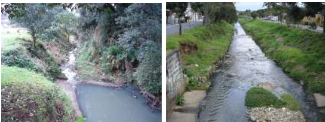
B) ) Erosão marginal e assoreamento do rio. Na foto à direita, detalhe do assoreamento do rio na Rua Des. Manoel de Lacerda Pinto – Tingui / Bacacheri.*
