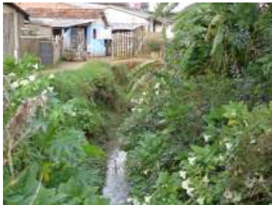
B) Ocupação desordenada nas margens do rio junto ao leito menor, na rua José Zaramella com rua Prof. Maria Balbina da Costa Dias – Boa Vista.*
