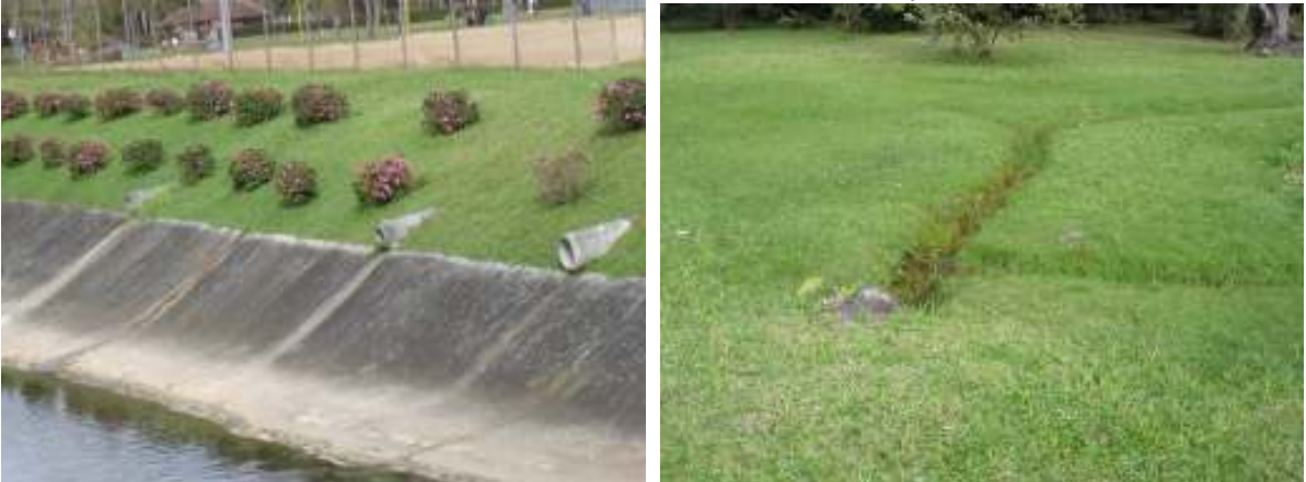
B) Dutos de drenagem de água do terreno para o canal do rio, no Parque Bacacheri e em propriedade particular ao lado do parque. Evidência de terrenos encharcados e saturação do solo pela proximidade do lençol freático com a superfície, características dos Gleissolos.*
